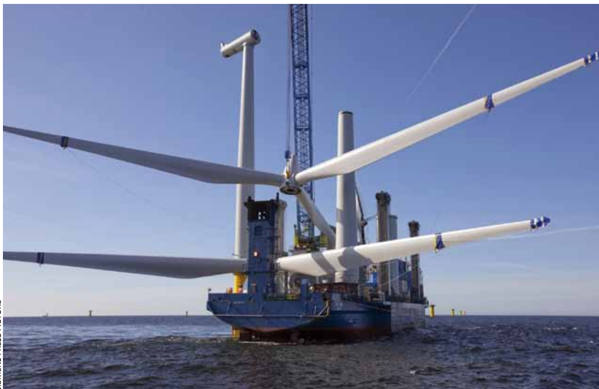
Transporte de aerogeradores para fazenda eólica offshore .
