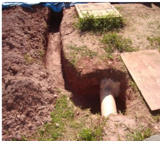
Tubulação nova para poço de sucção
