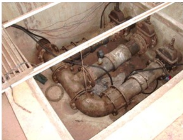
Vista das conexões de ferro da rede de recalque
