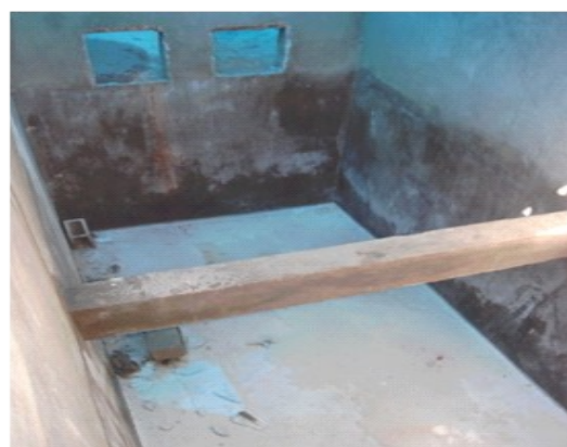
Novo poço de sucção já com as janelas para tubulação das bombas de sucção
