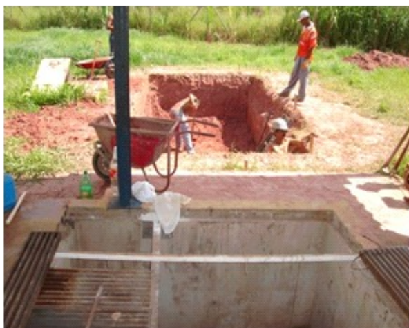
Início da escavação do novo poço de sucção e recalque
