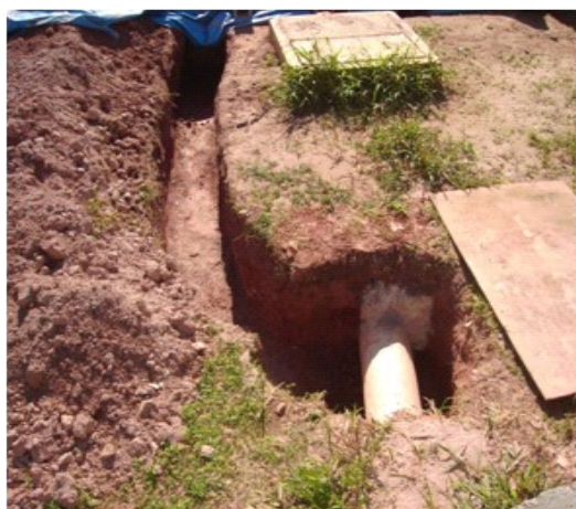
Tubulação nova para poço de sucção
