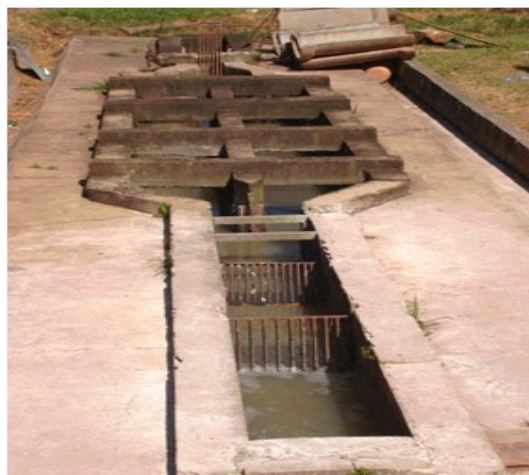
Vista da calha de remoção dos detritos antes da reforma
