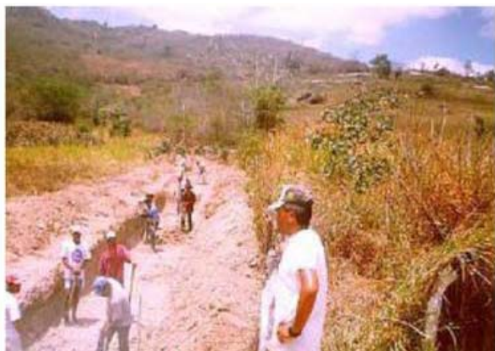
Figura 2 : Construcción de una presa sub-superficial en Brasil (izquierda) y una presa madura en Kenya (derecha)
