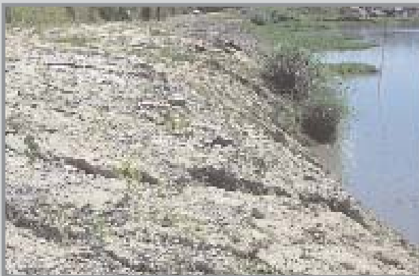
Sulcos de erosão nos taludes das cavas
