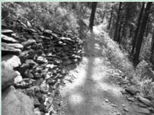
Figura 76 - Um muro de contenção em pedra retendo em posição um barranco íngreme escavado.
