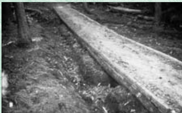
Figura 42 - A manutenção dos elevados inclui refazer o abaulamento central, limpar as valetas laterais e certificar-se de que estas sejam fundas o suficiente.
