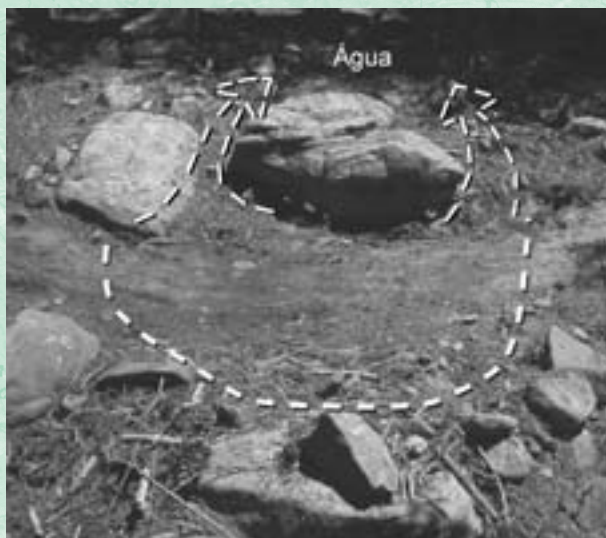
Figura 13 - Bolsões de escoamento construídos em trilhas já existentes drenam poças formadas em áreas planas.
