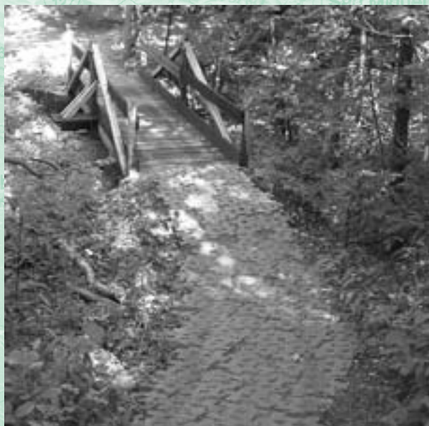
Figura 86 - Lajotas prontas de concreto podem ser usadas para reforçar trechos de trilhas para uso motorizado.
