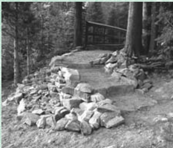
Figura 85 - Para uso com montarias, as plataformas devem ser longas o suficiente para colocar todas as quatro patas do animal, ou cerca de dois metros.
