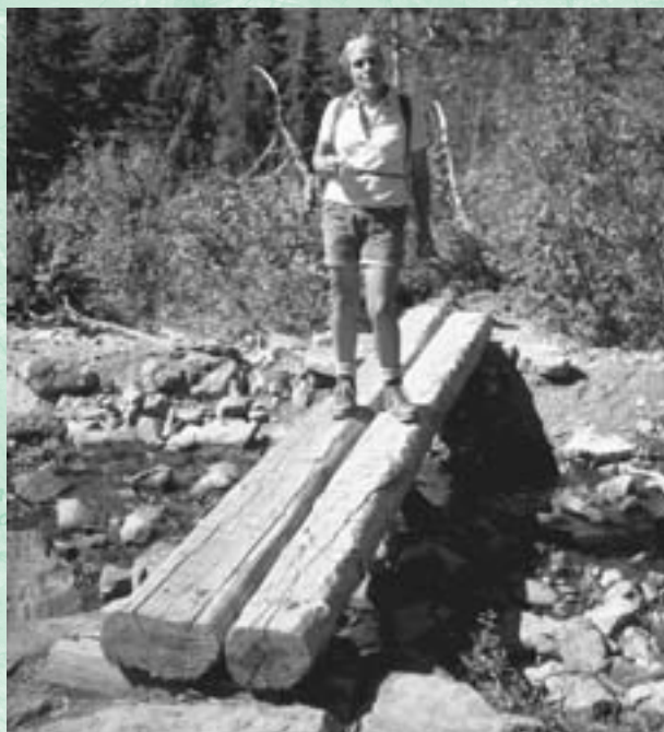
Figura 64 - Uma pinguela de troncos. Os dormentes de apoio nas extremidades podem ser entalhados para assentar os troncos, mas não o contrário. A foto foi digitalmente alterada.
