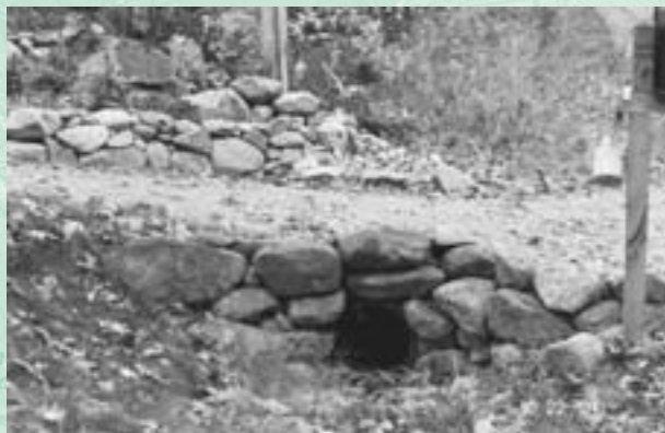
Figura 60 - Bueiros são ótima opção para a passagem de pequenos volumes d'água por baixo da trilha.
