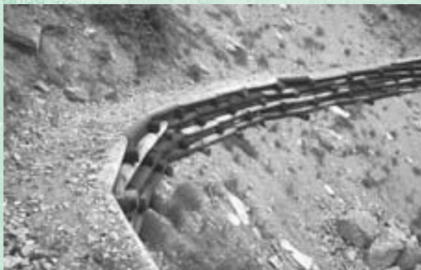
Figura 78 - Paliçada ajudam a manter o aterro compactado em posição.
