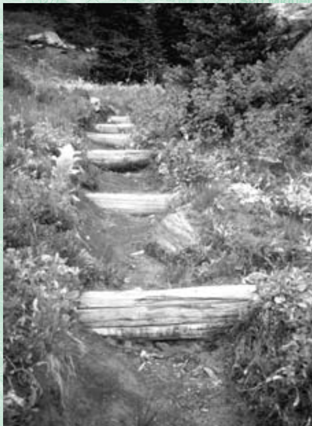
Figura 94 - Depois de alguns anos, esta canaleta deve acabar se reenchendo.
