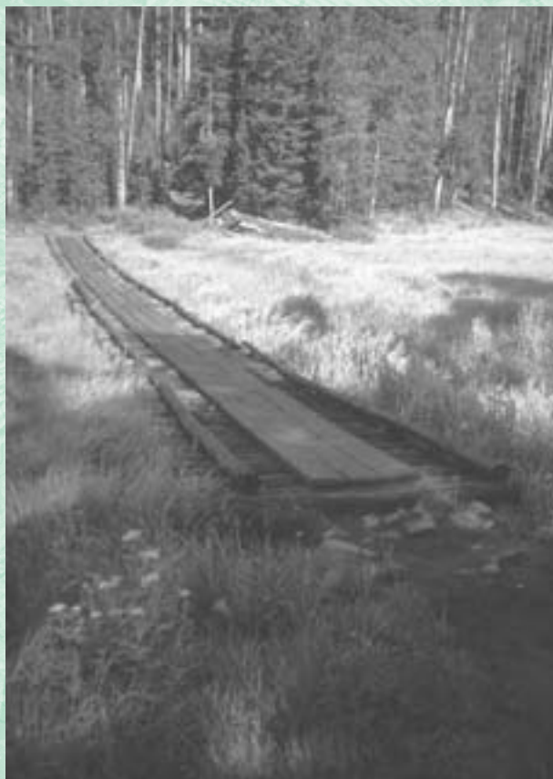
Figura 48 - Uma passarela padrão é ligeiramente elevada acima do solo.
