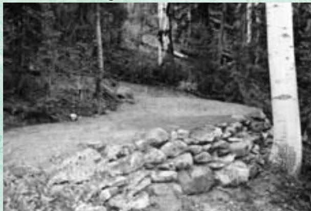
Figura 71 - Parte do acesso inferior e a metade inferior deste ziguezague são construídas sobre um aterro.
