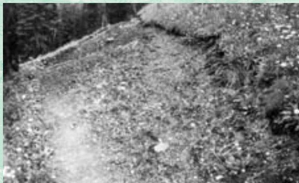
Figura 31 - Um caso clássico de deslizamento do piso. esta trilha precisa de providências agora, porque o piso está escorregando encosta abaixo.
