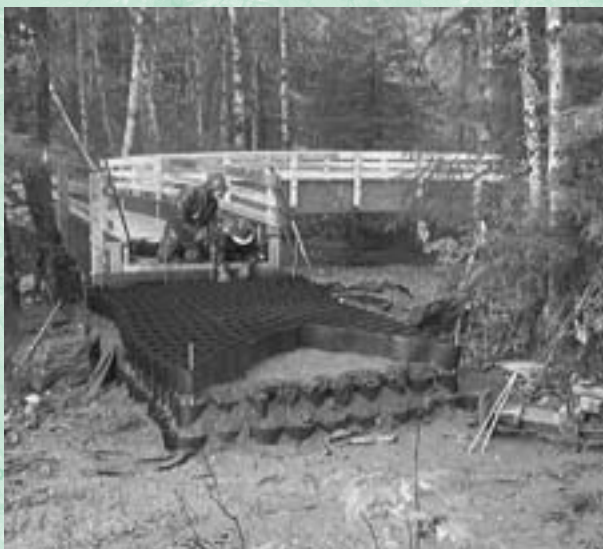
Figura 38 - Geocélulas são ótima solução para reforço do piso e para ajudar a manter o material do aterro no lugar.
