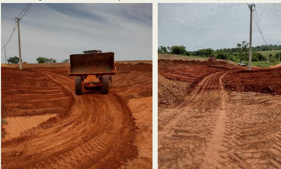
Figuras 2A e 2B. Manutenção de estrada rural realizada pelo CIRL
