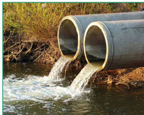
Descarga de esgoto em um rio.
