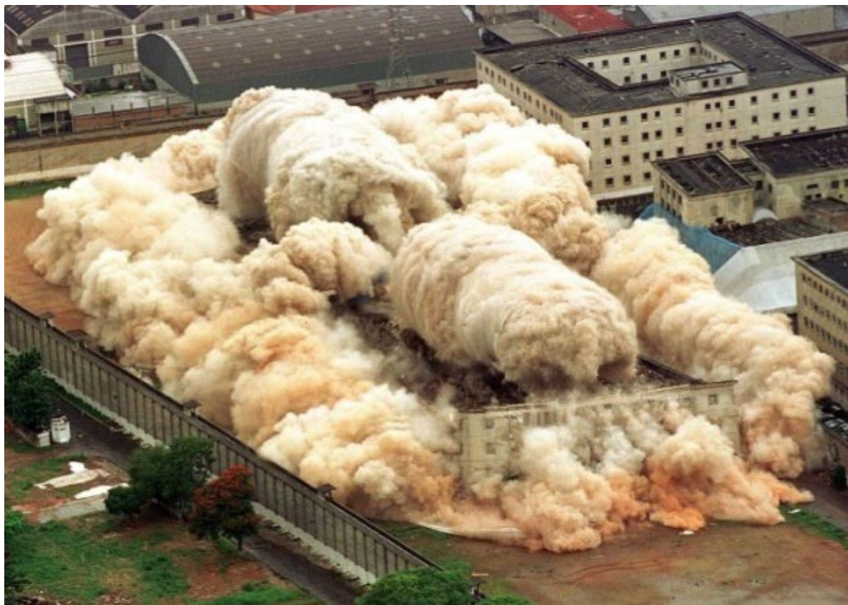
Figura 8: Implosão do Carandiru
