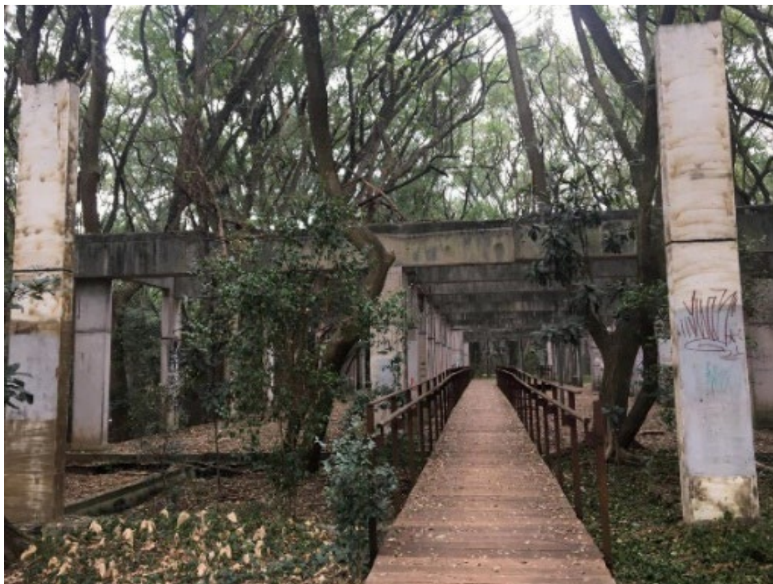
Figuras 25 e 26: Conjunto Estruturas Tombadas Antigo Complexo Penitenciário Fonte: Katia Guerreiro, 2024.
