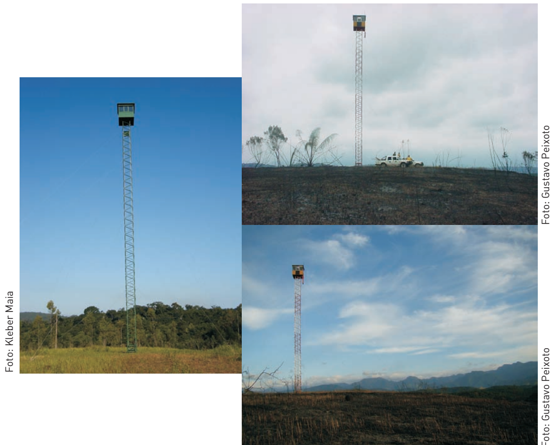
Figura 6 – Exemplos de estruturas construídas para vigilância da área e detecção dos incêndios florestais.
