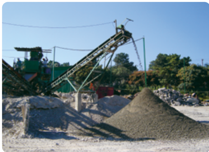
FIGURA 18 - USINA DE BENEFICIAMENTO DE RCC. Fonte: Wolmer / CETESB, 2008.
