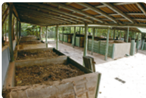
FIGURA 15 - PLANTA DE COMPOSTAGEM. Fonte: Arquivo Fundação Parque Zoológico, 2010.
