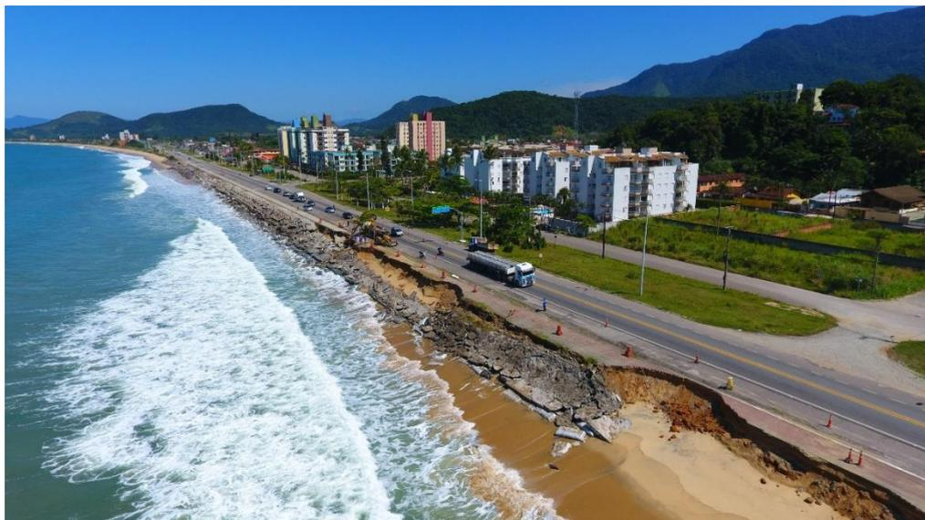
Praia de Massaguaçu, Caraguatatuba (2020). A erosão começou em 2000, e se estendia por cerca de 100 m na rodovia BR-101. Em 2022, após sucessivas obras inadequadas, a erosão já se expandia por cerca de 2.700 m.
