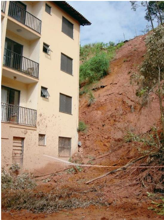
Escorregamento atinge base de edifício, construído próximo a talude de corte de alta declividade em Taboão da Serra (Janeiro de 2011). Foto: Acervo IG.
