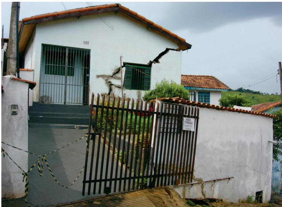
Trincas em moradia provocadas por subsidência de solo em terreno cárstico em Guapiara (Fevereiro de 2010).
