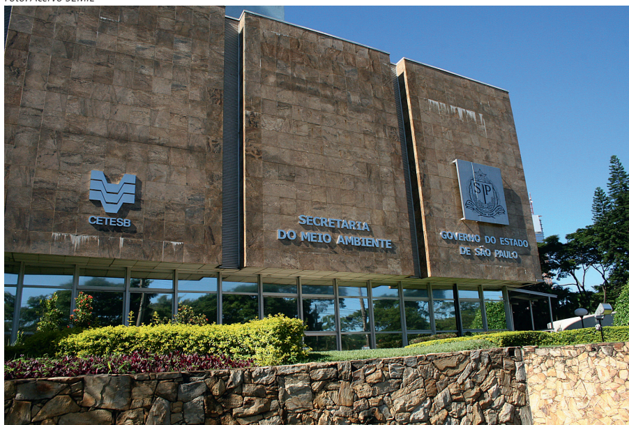
FIGURA 24 – FACHADA DA SECRETARIA DO MEIO AMBIENTE, INFRAESTRUTURA E LOGISTICA.
