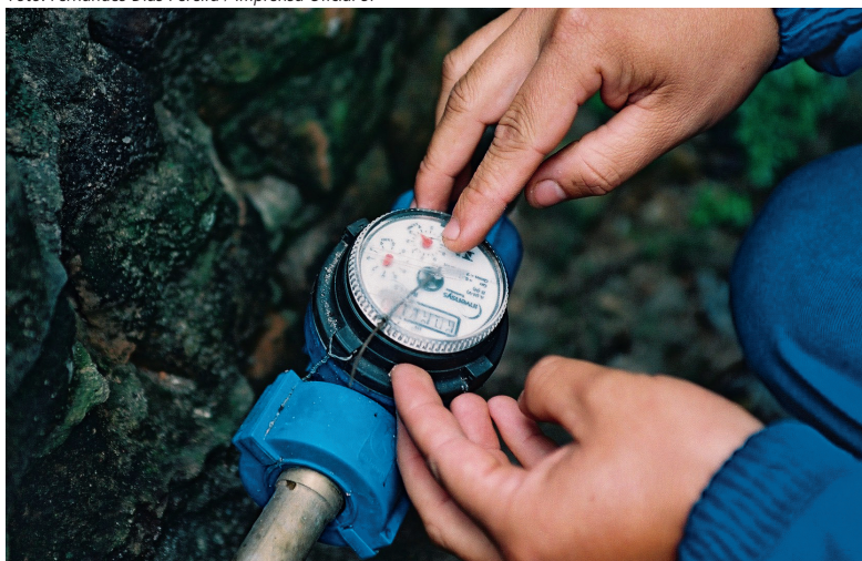
FIGURA 27 – VERIFICAÇÃO DE HIDRÔMETRO.
