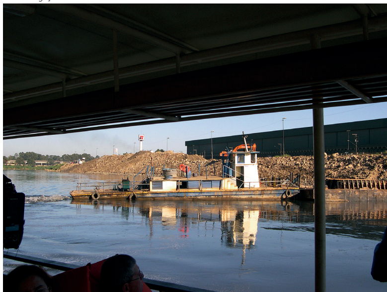
FIGURA 14 – OBRAS NO RIO TIETÊ.
