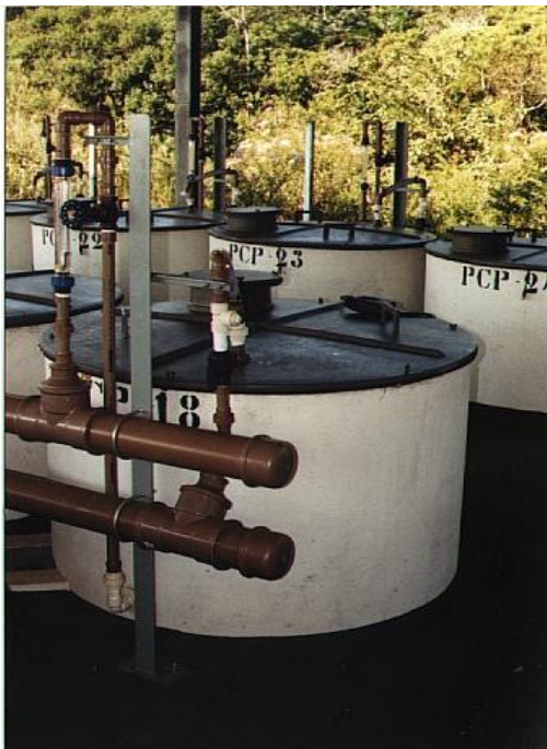
Figura 6: Reatores utilizados em processos de biorremediação de solo contaminado com organoclorados (Fotos: Ricardo R. da Silva 2004)
