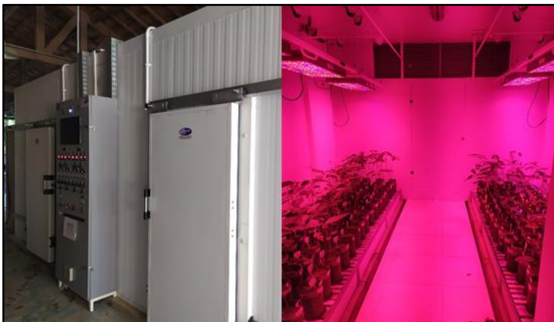
Figura 1. Câmara climatizada inserida no Instituto de Pesquisa Ambientais.
