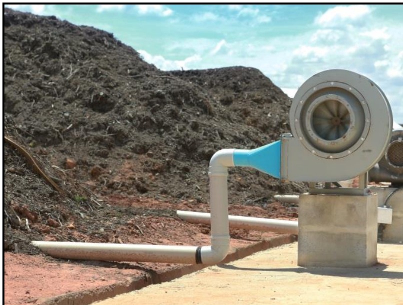
Figura 4. Sistema de aeração forçada utilizado durante 60 primeiros dias do processo de compostagem.
