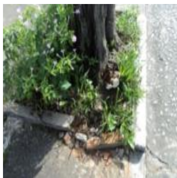
Detalhe do canteiro
