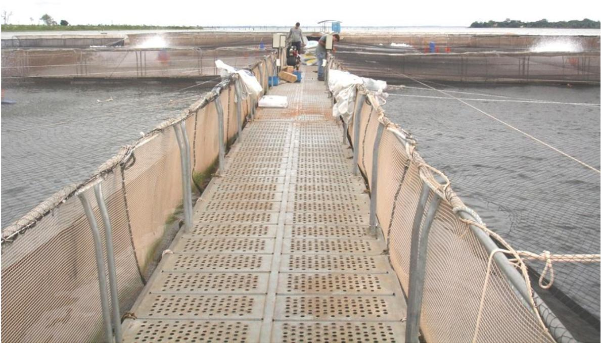
Figura 10. Imagem da estrutura de um dos módulos de oito tanques-rede de grande volume utilizados na fazenda de engorda da piscicultura Geneseas Aquacultura. Fonte: Edna F.Rosini (2012).
