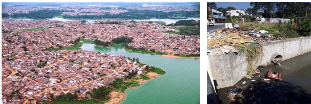
Figura 6. Imagens do entorno da represa Guarapiranga, destacando área de uso urbano de baixo padrão e despejo de esgoto na represa (Fonte www.riosdobrasil.com.br , consulta: jun/2011).
