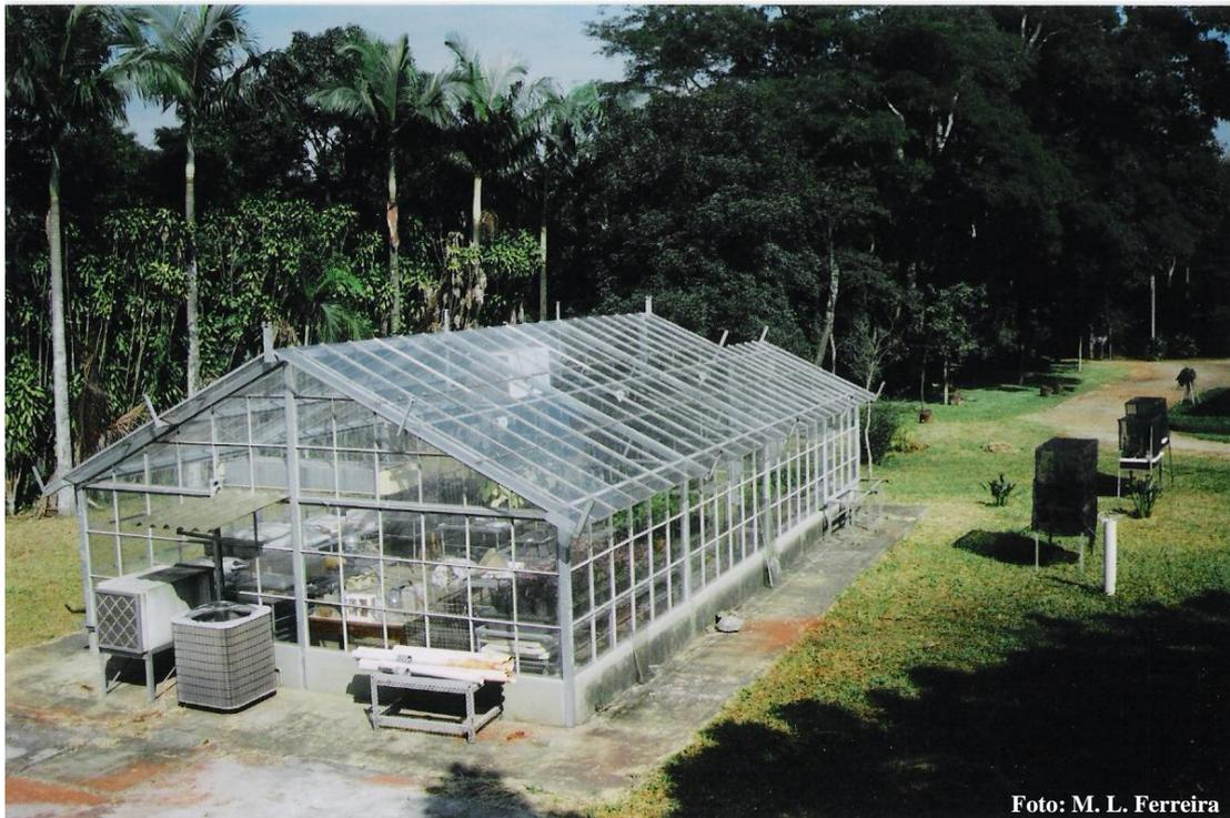
Figura 3. Casa de vegetação com filtros para de gases e partículas e controle de temperatura situada no Instituto de Botânica, onde foi mantido o material de referência.
