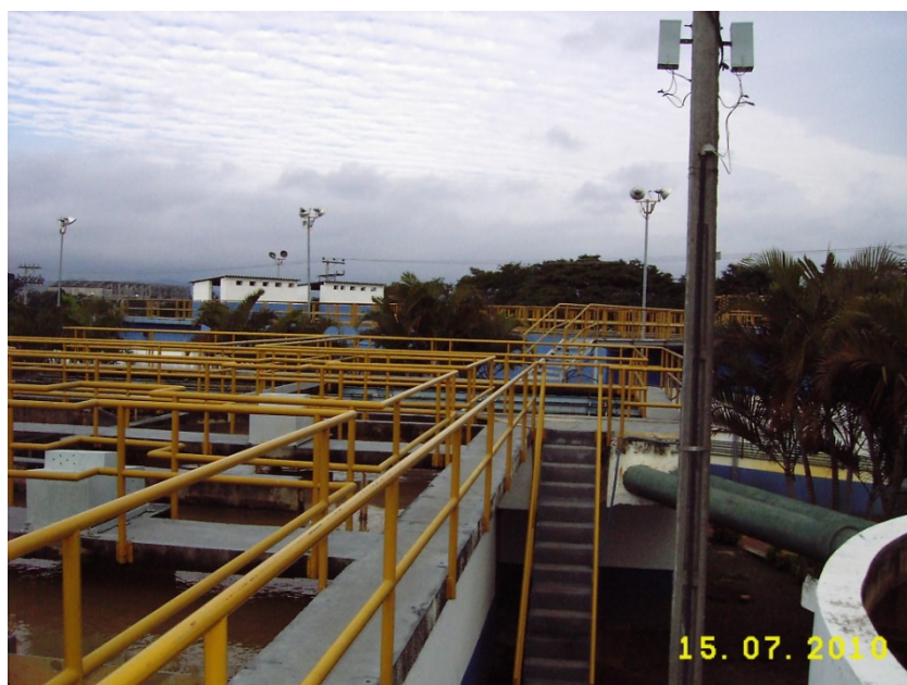
Foto 01 – ETA – Floculadores mecanizados.
