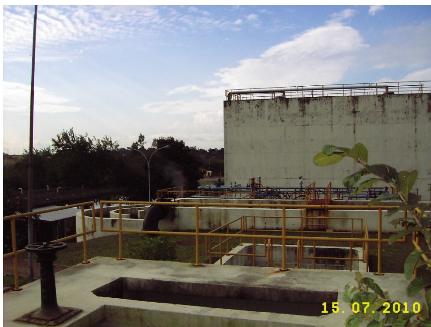
Foto 02 – ETE – Caixa de entrada e tanque de aeração.
