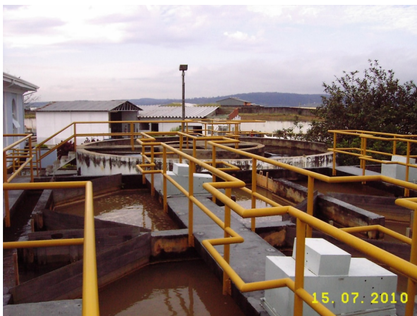
Foto 02 – ETA – Floculadores e decantador circular.
