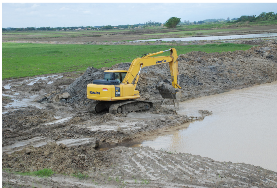
FOTOGRAFIA 11 - Preparação da atividade de extração de areia em cava, pelo método da dragagem por sucção, com a retirada do capeamento argilo-turfoso que recobre os níveis arenosos do cinturão meândrico. Porto Morro Vermelho, Guaratinguetá. (Fotografia: nov/2011)
