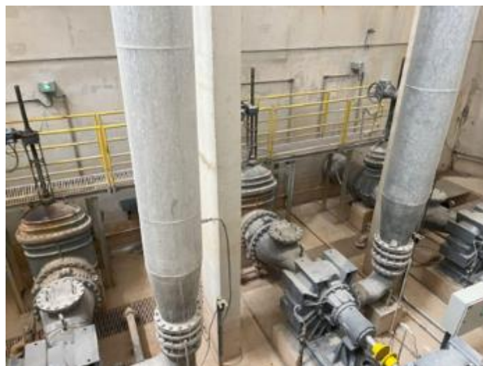
Modernização da EEE Itaquaquecetuba
