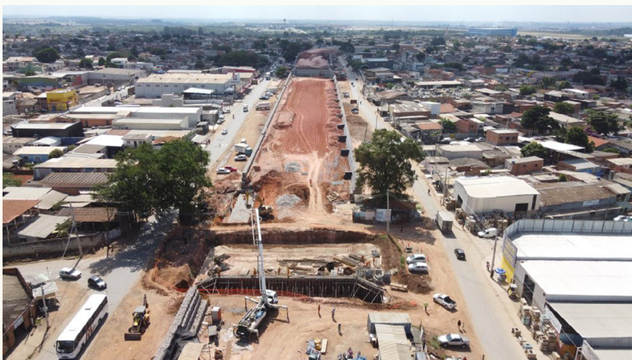
Obras na SP 324
