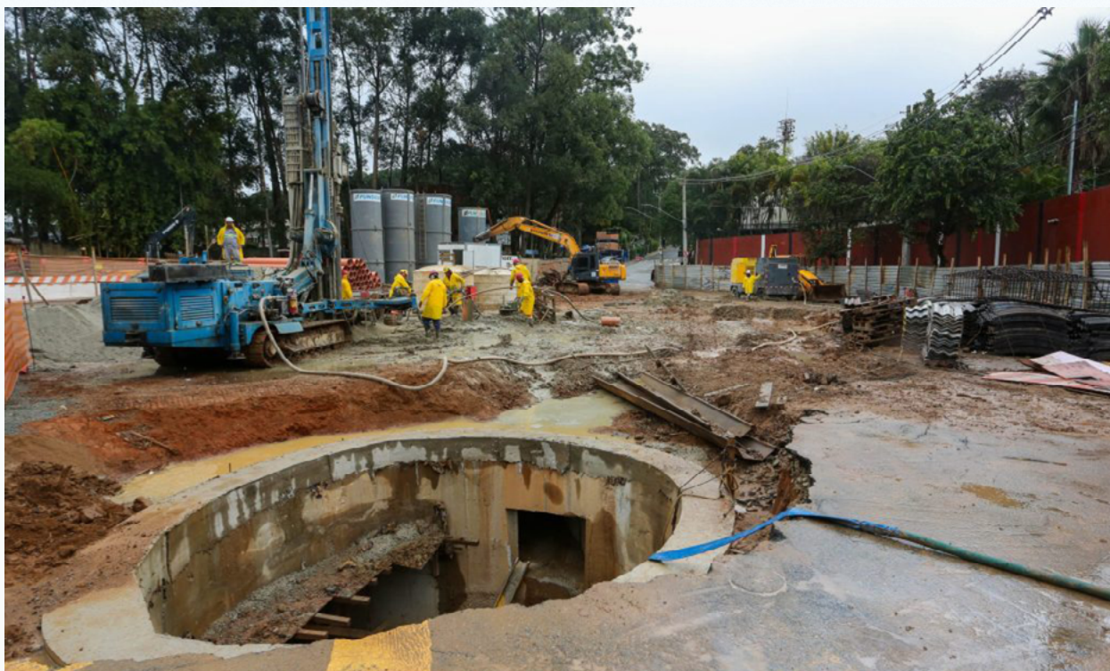
Obras do piscinão do Córrego Antonico
