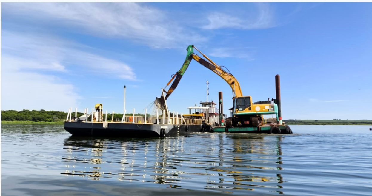
Retirada de sedimentos do canal de acesso de Nova Avanhandava
