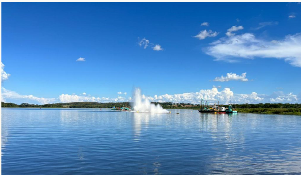
Derrocamento do canal de acesso de Nova Avanhandava
