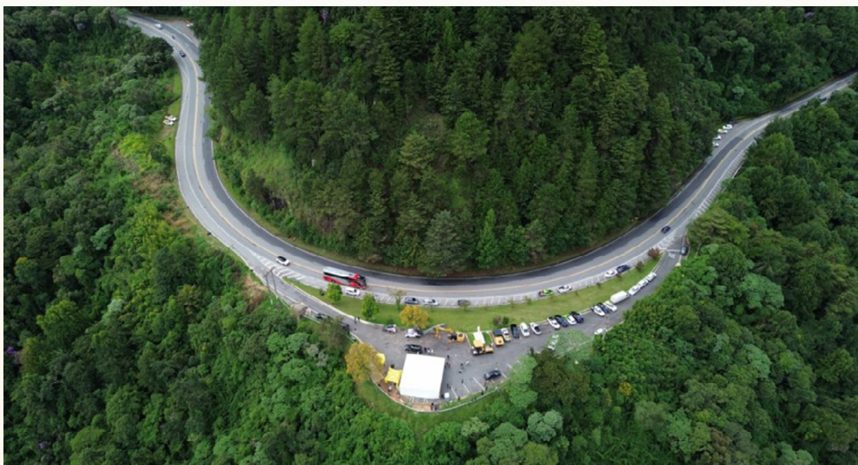
Modernização da SP 123
