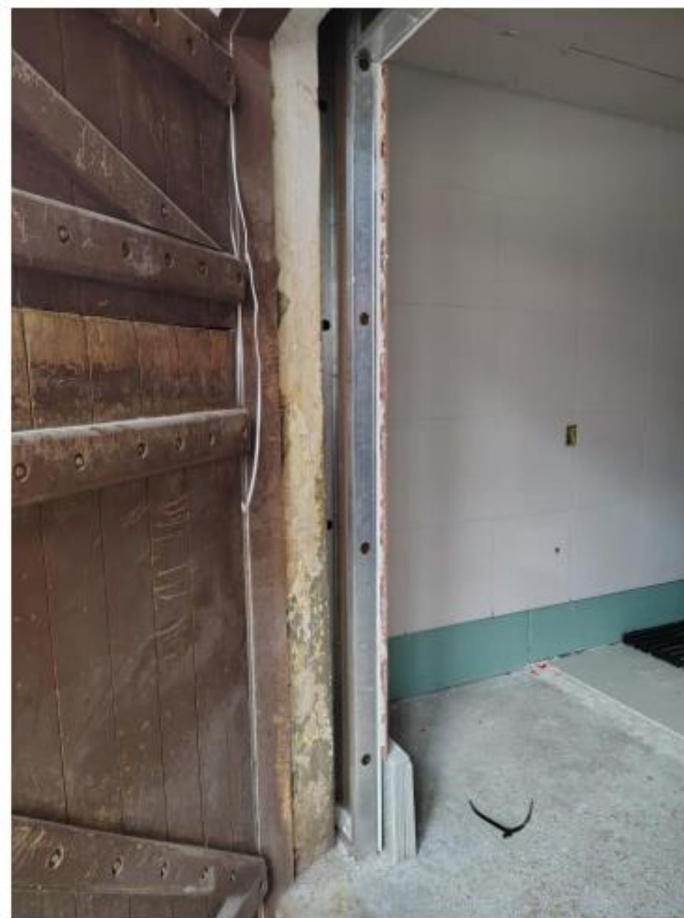
Estábulo com intervenção em razão do Evento Fazenda Churrascada: instalação de placas de MDF na parede do estábulo e aplicação de azulejos na placa de MDF
