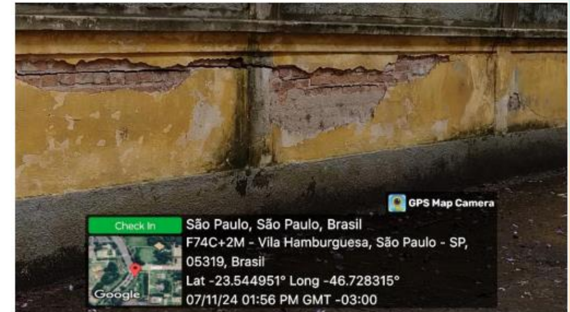
Tijolos expostos, rachaduras e sinais de infiltração
