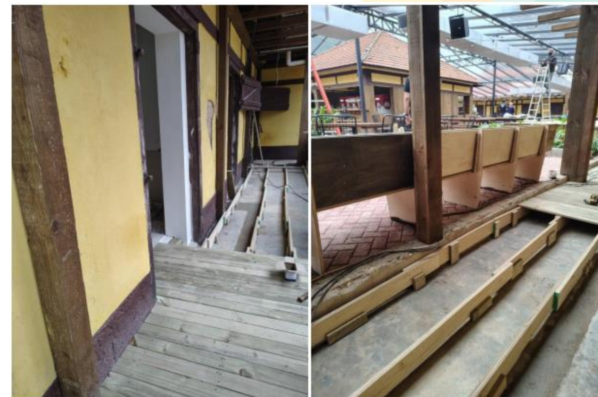
Estrutura de piso elevado para nivelamento – Fazenda Churrascada
