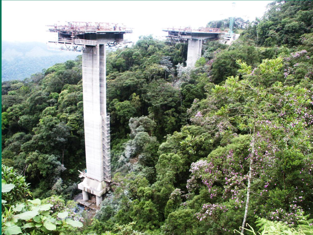
Baixo impacto sobre a cobertura vegetal nas travessias dos vales por pontes e viadutos
