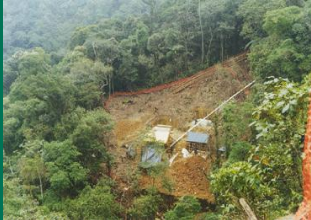
Controle da supressão da vegetação nos emboques dos túneis
