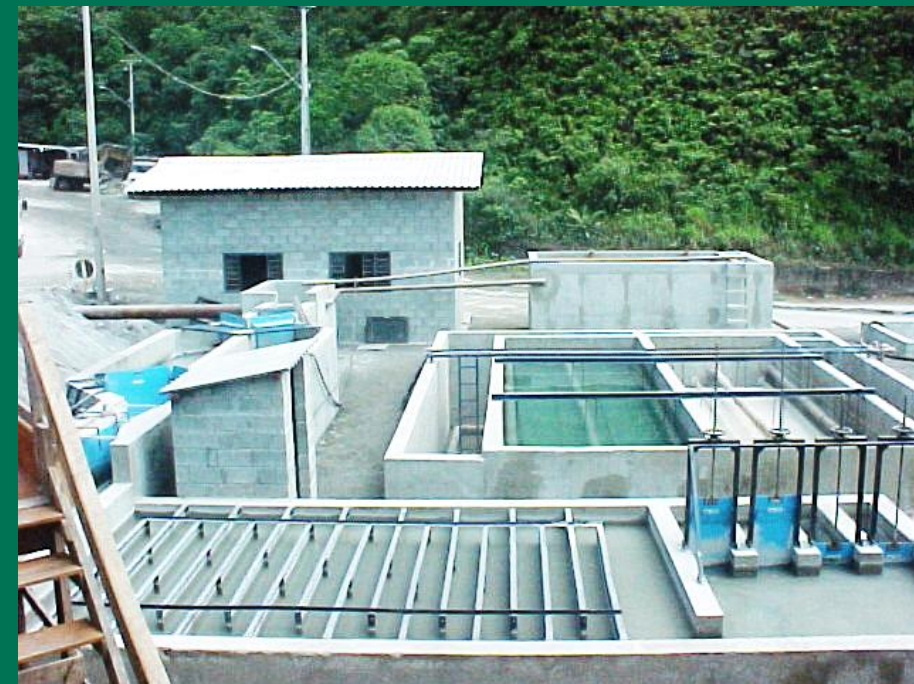
Estação de Tratamento de Água de Infiltração
