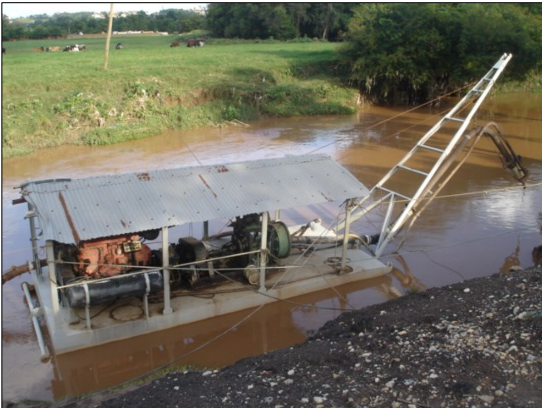
Foto 54 - Sistema de dragagem de areia (bombeamento de polpa) montado sobre barcaça semi-móvel em cava submersa (Gouvea Comércio de Areia).
