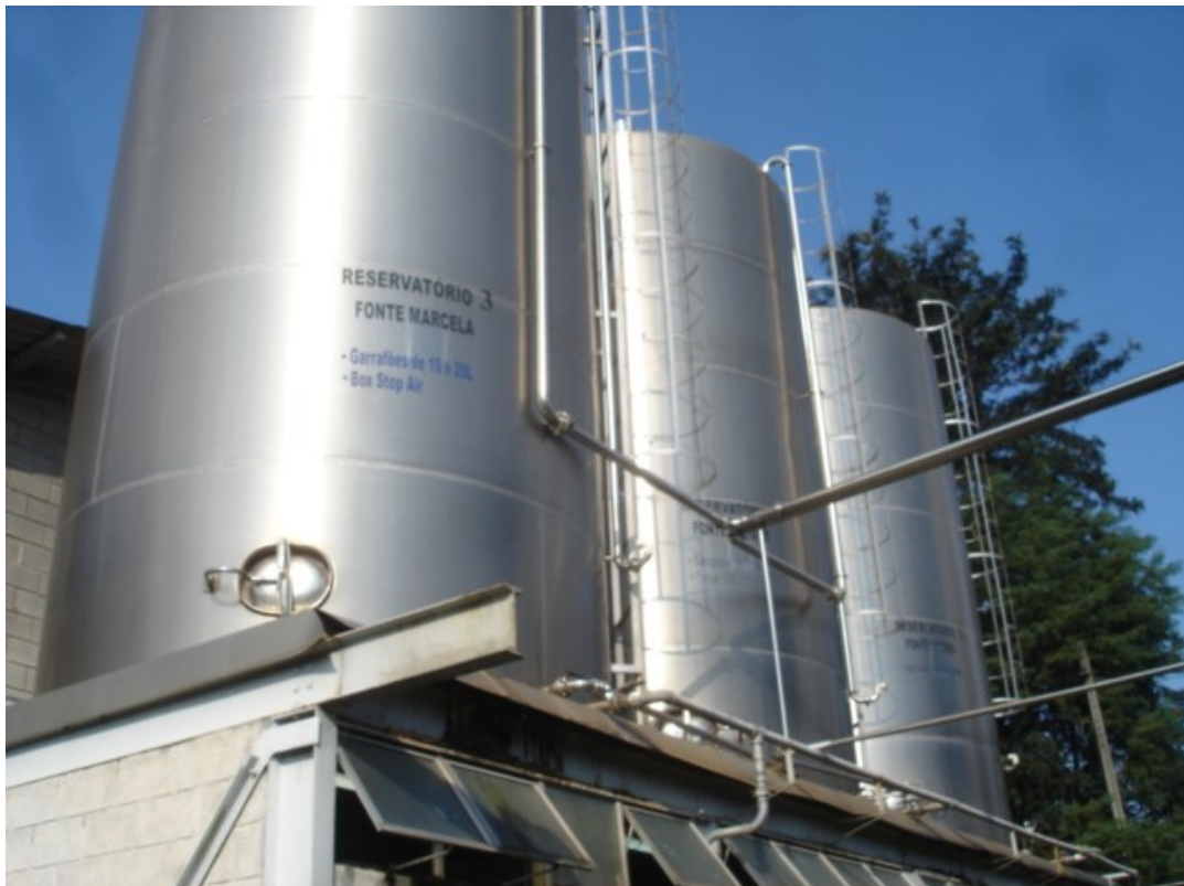
Foto 91 - Tanques em aço inoxidável para armazenamento de água mineral proveniente das fontes (Mineradora Vassoural).
