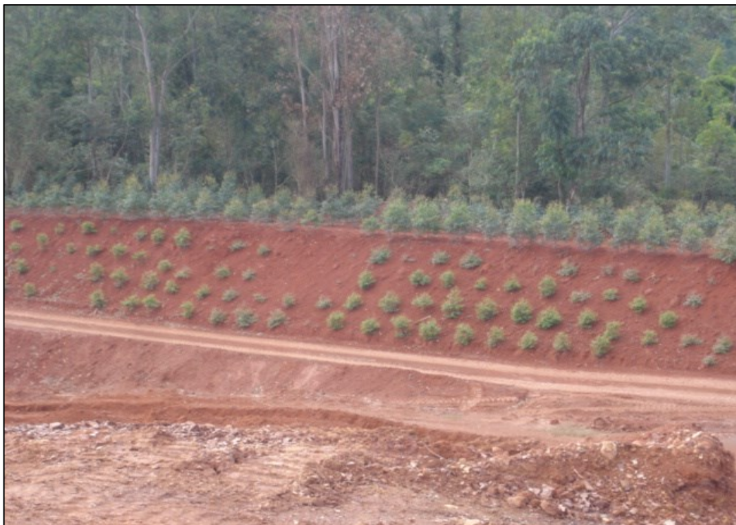
Foto 72 - Reflorestamento de taludes definitivos no contorno da área de lavra de argila (Extrativa Campo Largo).
