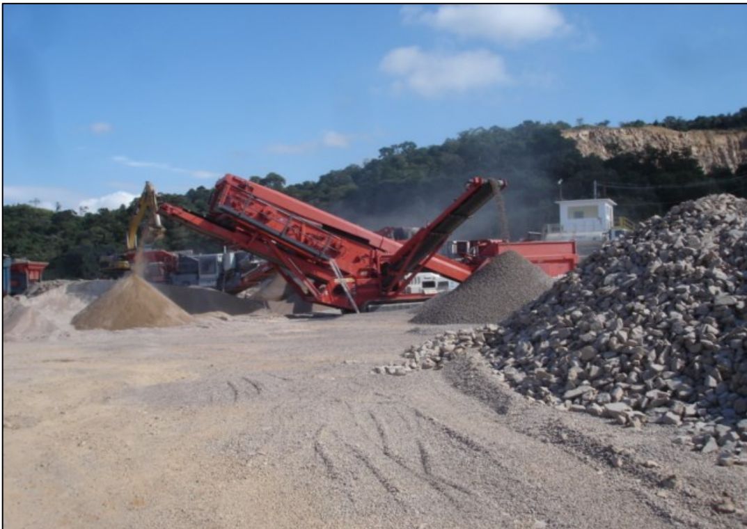
Foto 18 - Instalações (unidades móveis) de beneficiamento da brita (Pedreira Embu).
