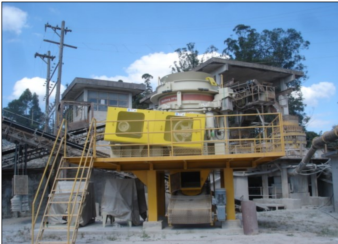
Foto 10 - Em primeiro plano, equipamento novo de britagem adquirido pela empresa, em fase de instalação (Pedreira Tavares Pinheiro).
