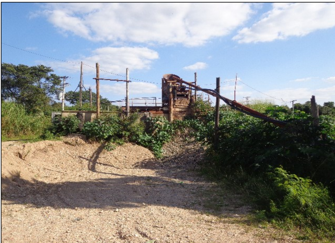
Foto 36 - Vista geral das instalações paralisadas de produção de areia (Porto de Areia Rio Branco/Itabrás Mineração).
