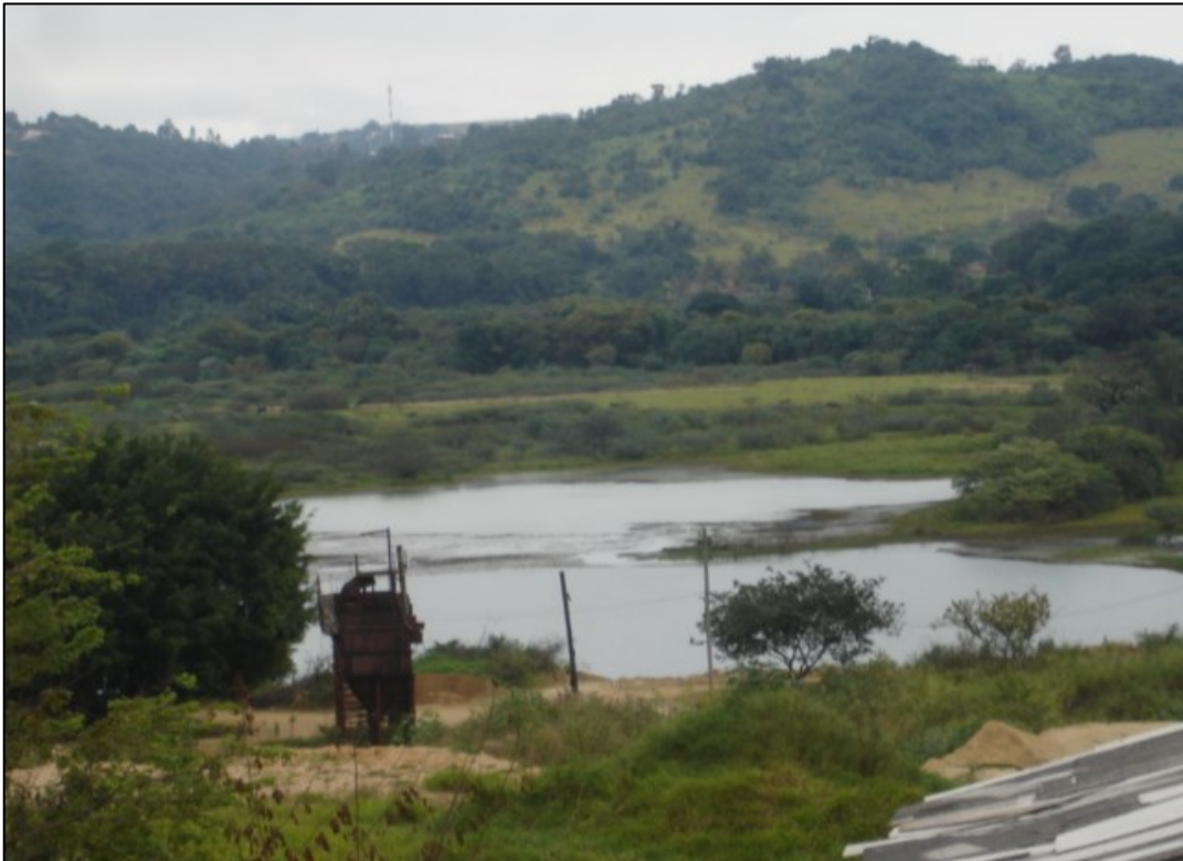
Foto 43 - Formação de lago em área já minerada, de onde é utilizada a água em circuito fechado nas operações de bombeamento de polpa (Della Serra Mineração).
