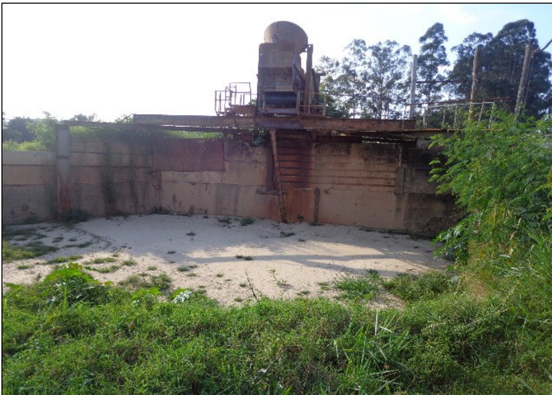
Foto 38 - Pátio de estocagem de produção (paralisada) de areia (Porto de Areia Rio Branco/Itabrás Mineração).
