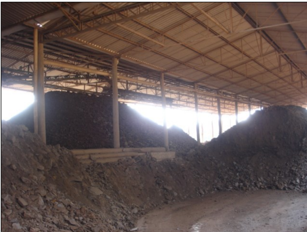
Foto 66 - Interior do galpão de armazenagem de argila (Mineração Gresca).
