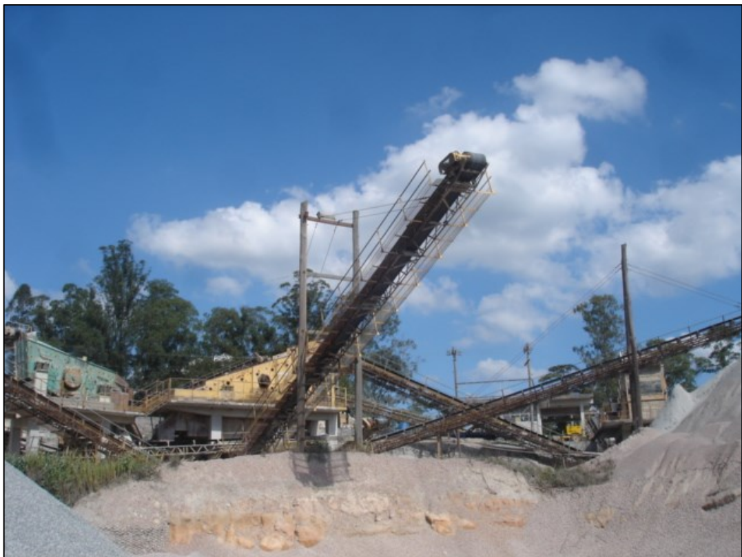
Foto 8 - Instalações de beneficiamento da brita (Pedreira Tavares Pinheiro).
