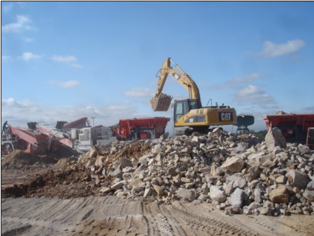
Foto 19 - Operação de alimentação do britador primário (Pedreira Embu).
