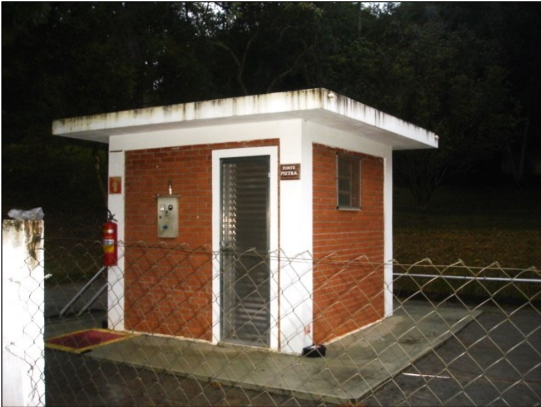
Foto 99 - Instalações da Fonte Pietra de água mineral (Classe Brasil Mineração).
