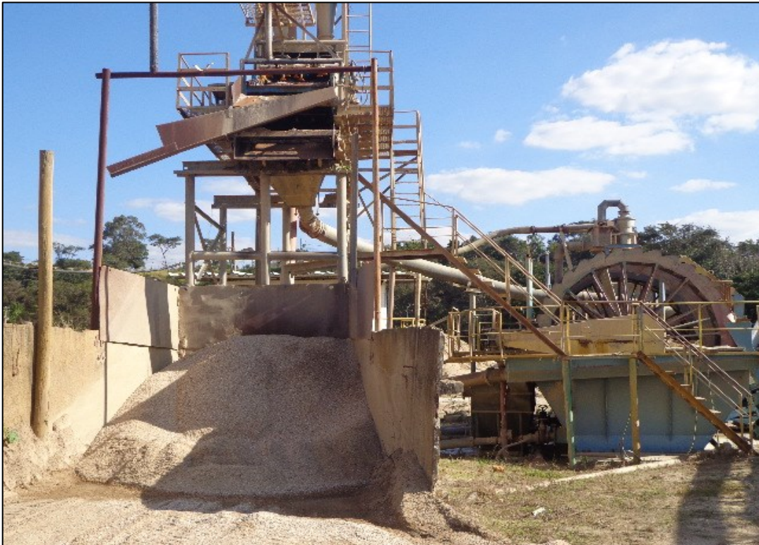
Foto 33 - Equipamentos utilizados nas operações de classificação granulométrica (Itabrás Mineração).
