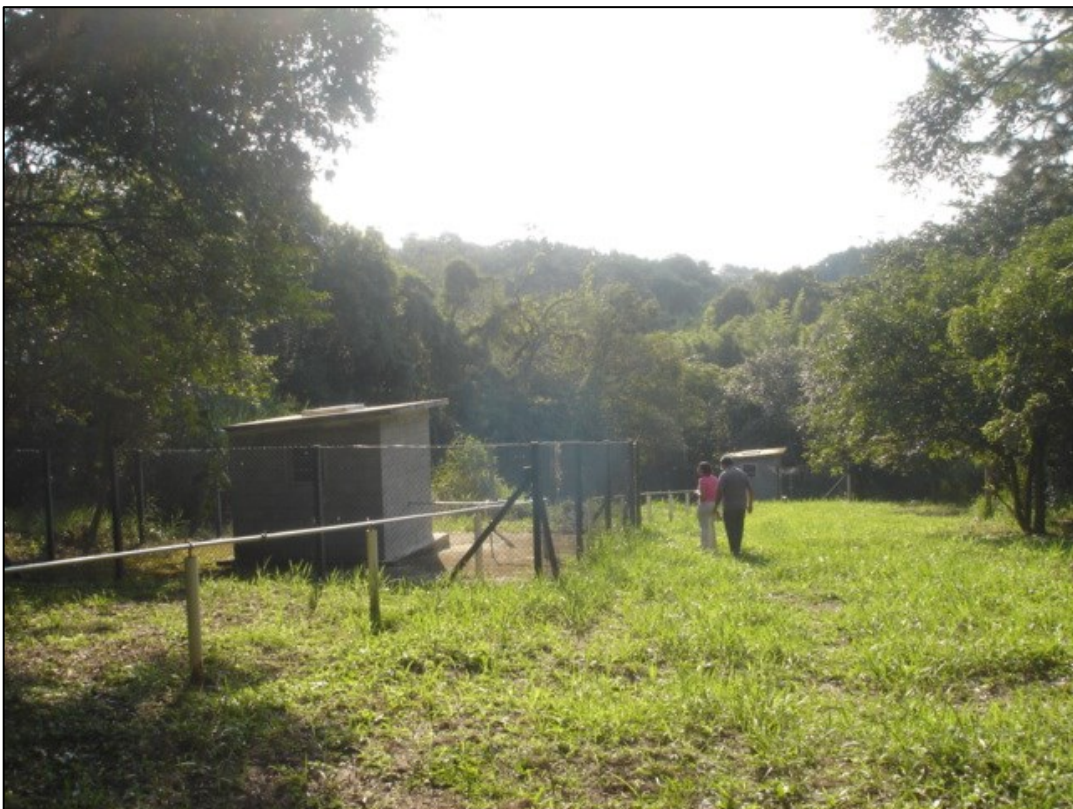
Foto 94 - Vista geral do entorno das fontes de água mineral (Mineradora Vassoural).
