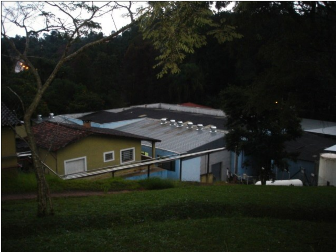
Foto 95 - Vista geral externa das instalações industriais de produção de água mineral (Classe Brasil Mineração).
