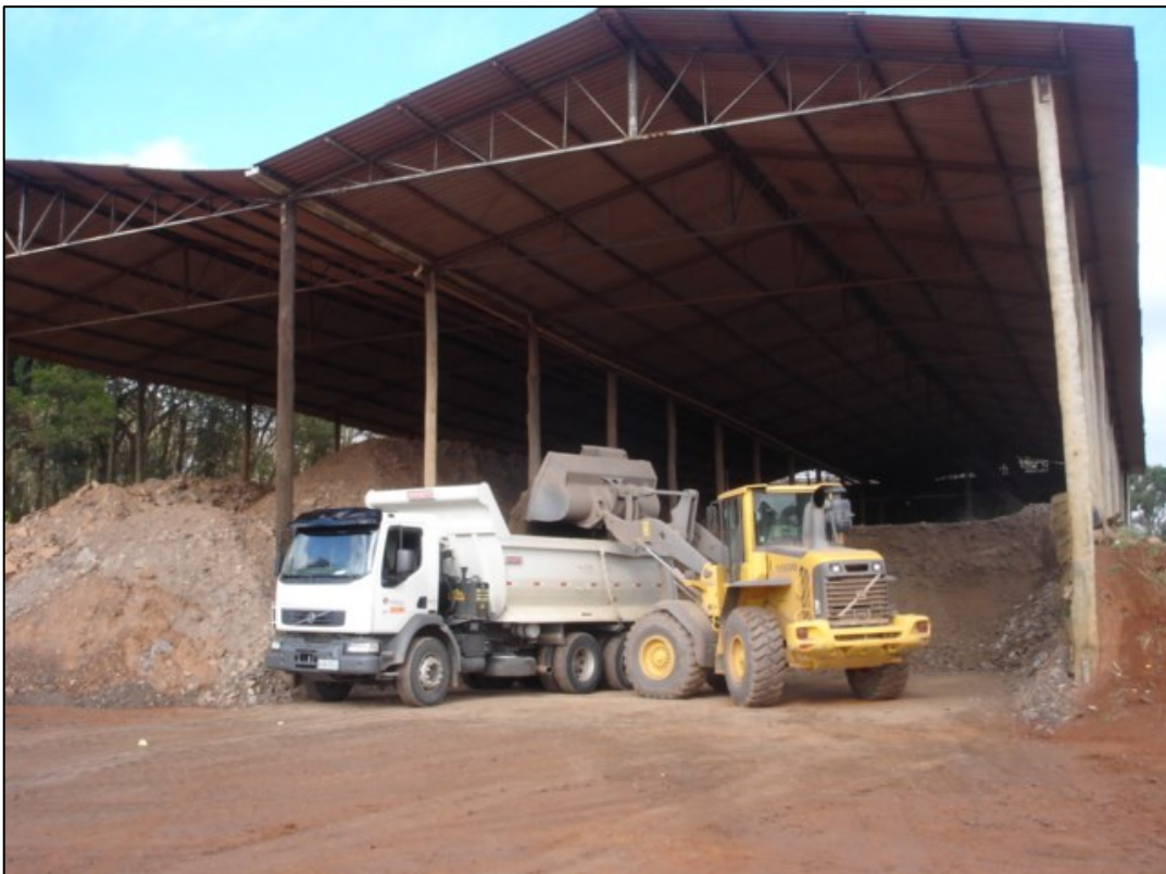
Foto 64 - Galpão de armazenagem e operação de carregamento de argila para transporte ao britador (Mineração Gresca).
