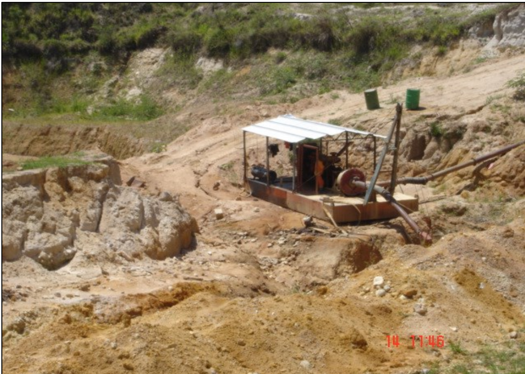
Foto 46 - Sistema de bombeamento de polpa de areia (Della Serra Mineração).
