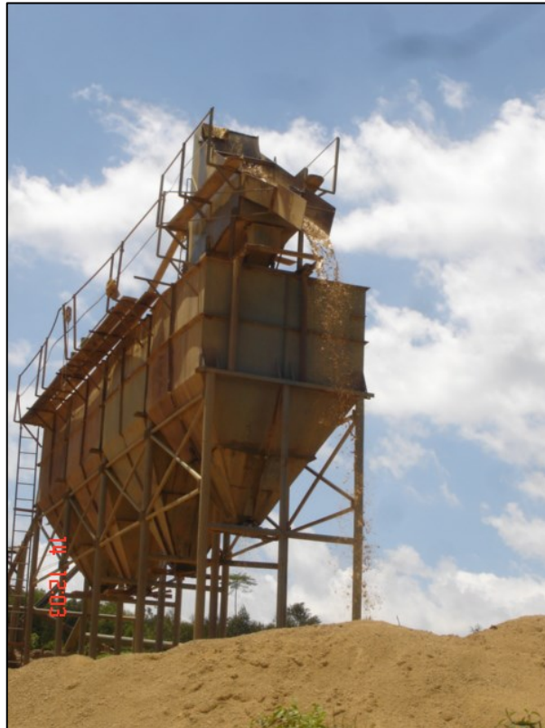
Foto 47 - Classificação por peneiramento estático e silos de armazenamento de areia classificada (Della Serra Mineração).
