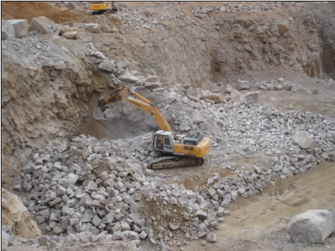
Foto 25 - Escavadeira hidráulica operando com sistema drop-ball de fragmentação secundária dos matacões de rocha (Pedreira Pinhal).
