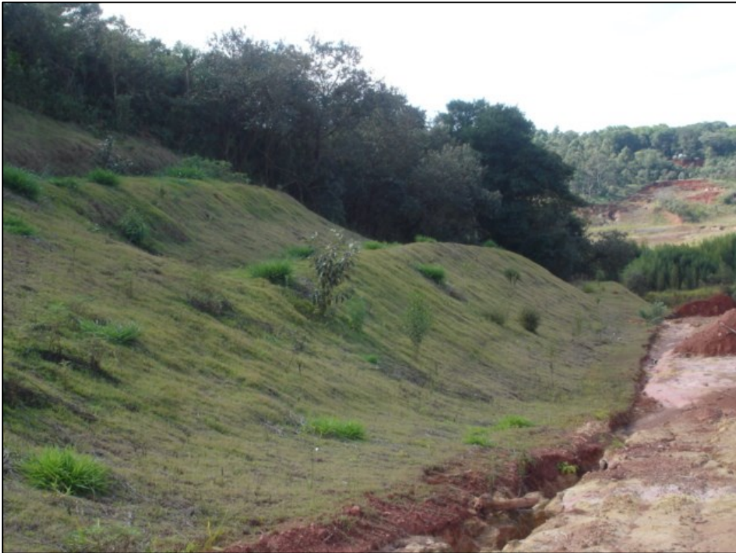
Foto 79 - Detalhe da formação dos taludes definitivos no contorno da área de lavra de argila (Cerâmica Ibetel).
