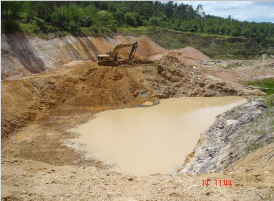
Foto 45 - Frente de lavra atual com operações de escavação mecânica de encosta e jateamento hidráulico para formação de polpa que é transferida por bombeamento (Della Serra Mineração).
