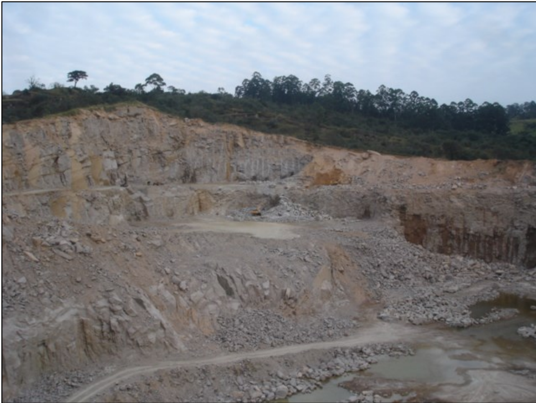
Foto 23 - Vista geral da área de lavra atual (Pedreira Pinhal).
