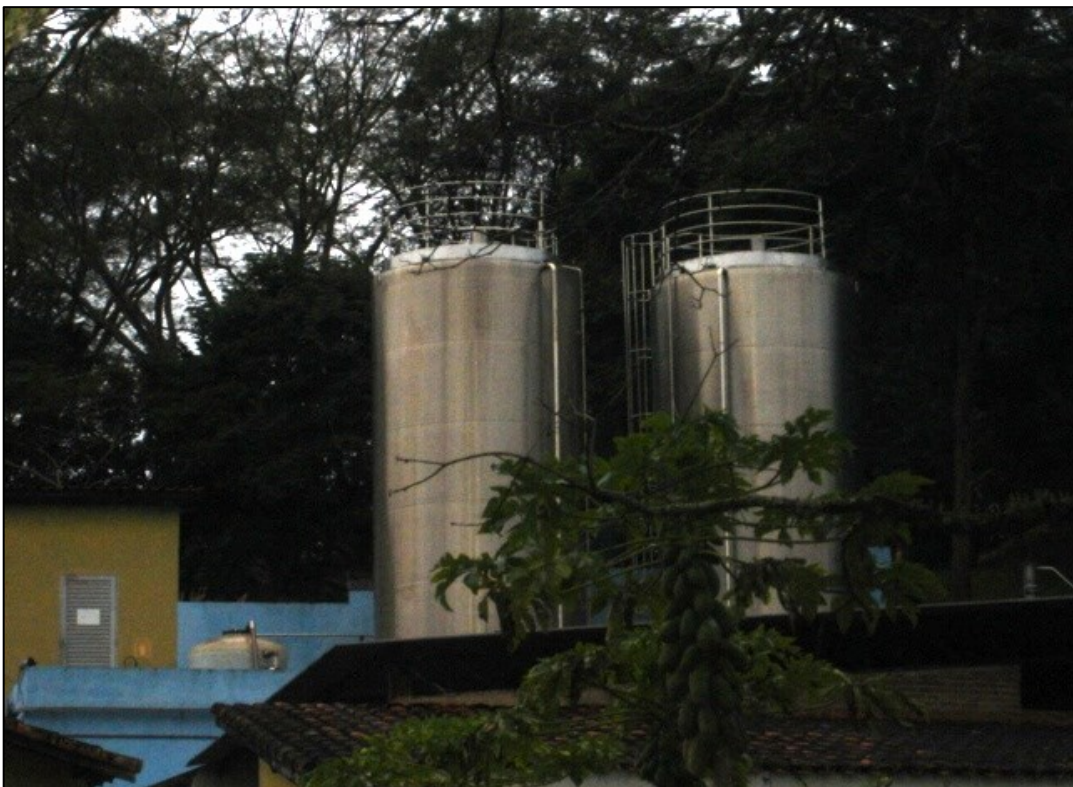
Foto 96 - Tanques em aço inoxidável para armazenamento de água mineral proveniente das fontes (Classe Brasil Mineração).
