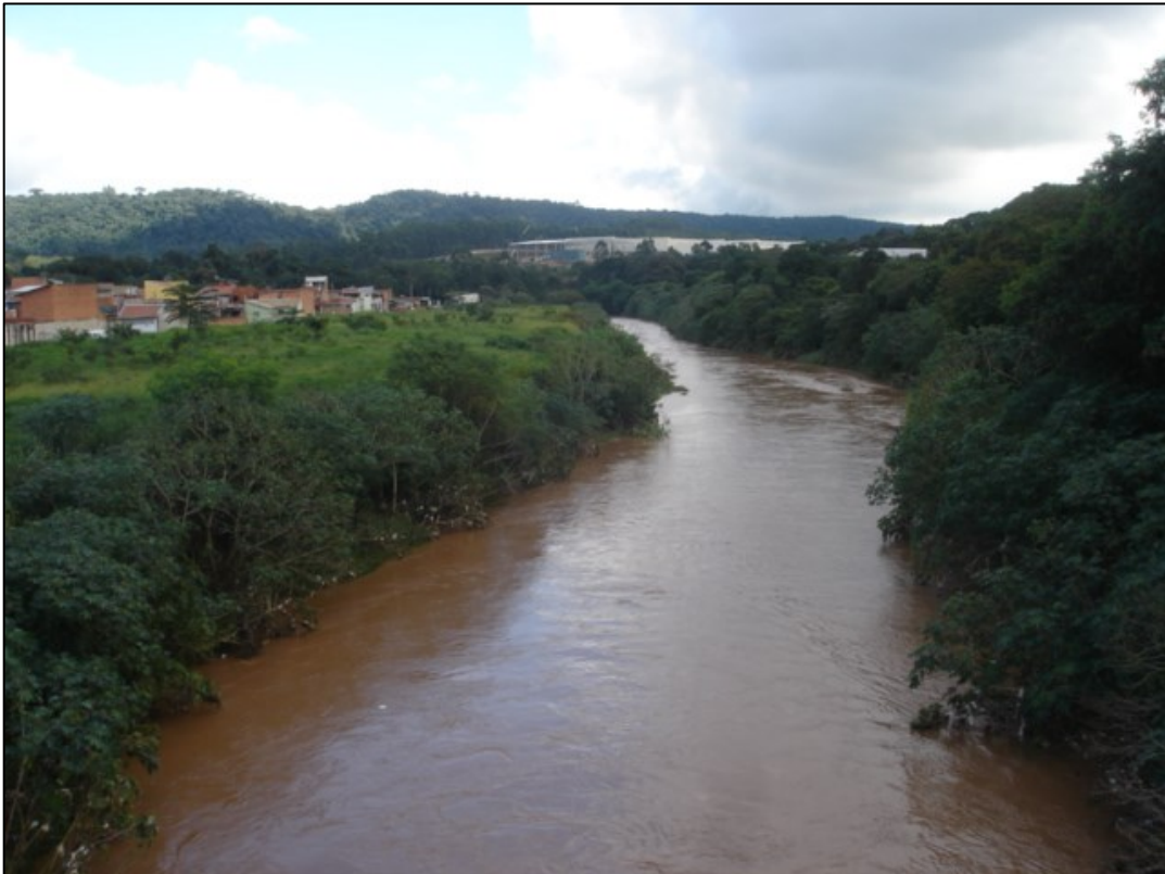
Foto 49 - Vista geral do trecho de operação da dragagem de areia no leito do rio Jundiá, cuja margem esquerda é ocupada por moradias (Edson Farinha).
