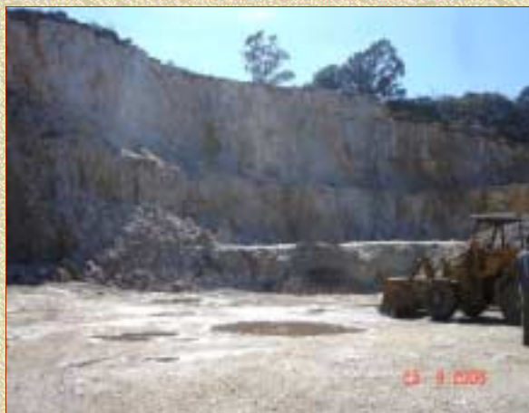
Frente de lavra ativa com bancadas irregulares..
