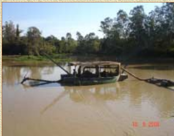
Draga com bombeamento direto para o caminhão.
