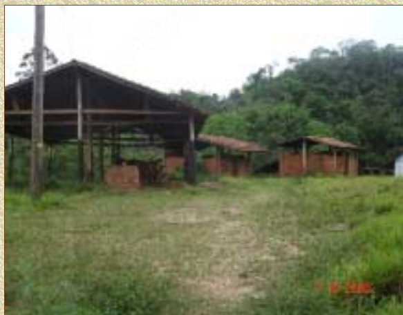
Vista geral da olaria, já desativada. Antigo pátio de secagem, galpão de produção e fornos caipiras.
