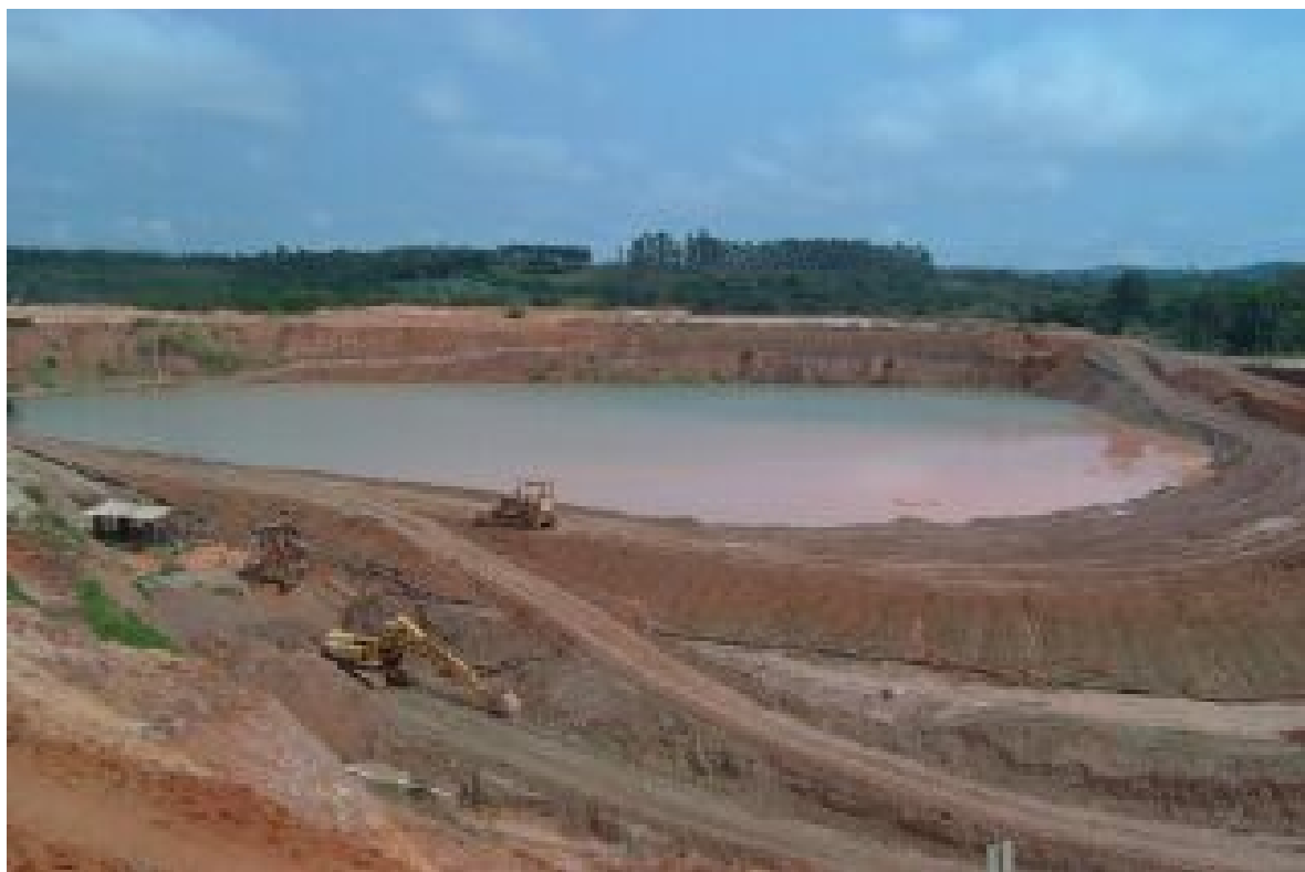
Foto 9 – Bacia de disposição de rejeitos e de armazenamento da água para operação em circuito fechado (integração da Cachoeira com a Ponte Alta da Mineração Itaquareia).
