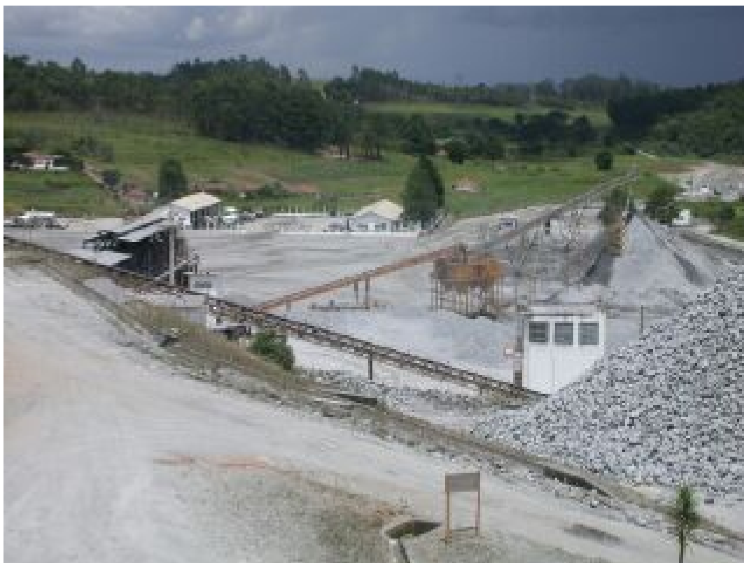
Foto 23 – Vista geral da área de beneficiamento e escritórios.
