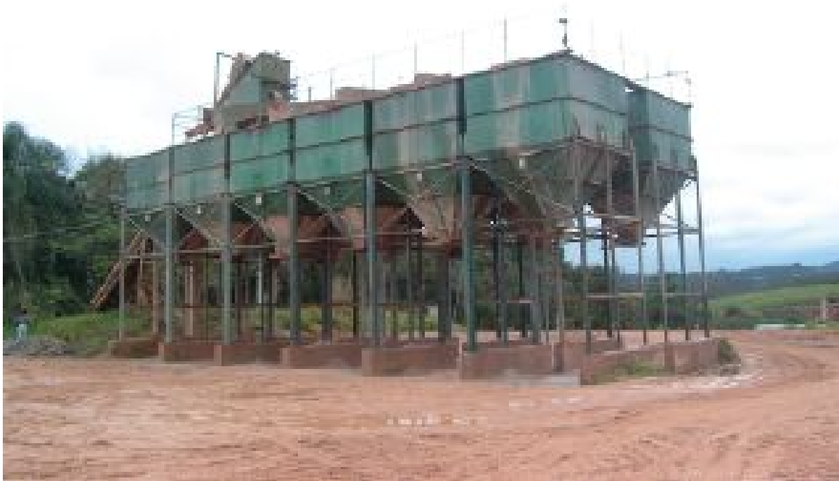
Foto 1 - Sistema típico de armazenagem de areia em silos para descarregamento nos caminhões (Mineração Taboão).
