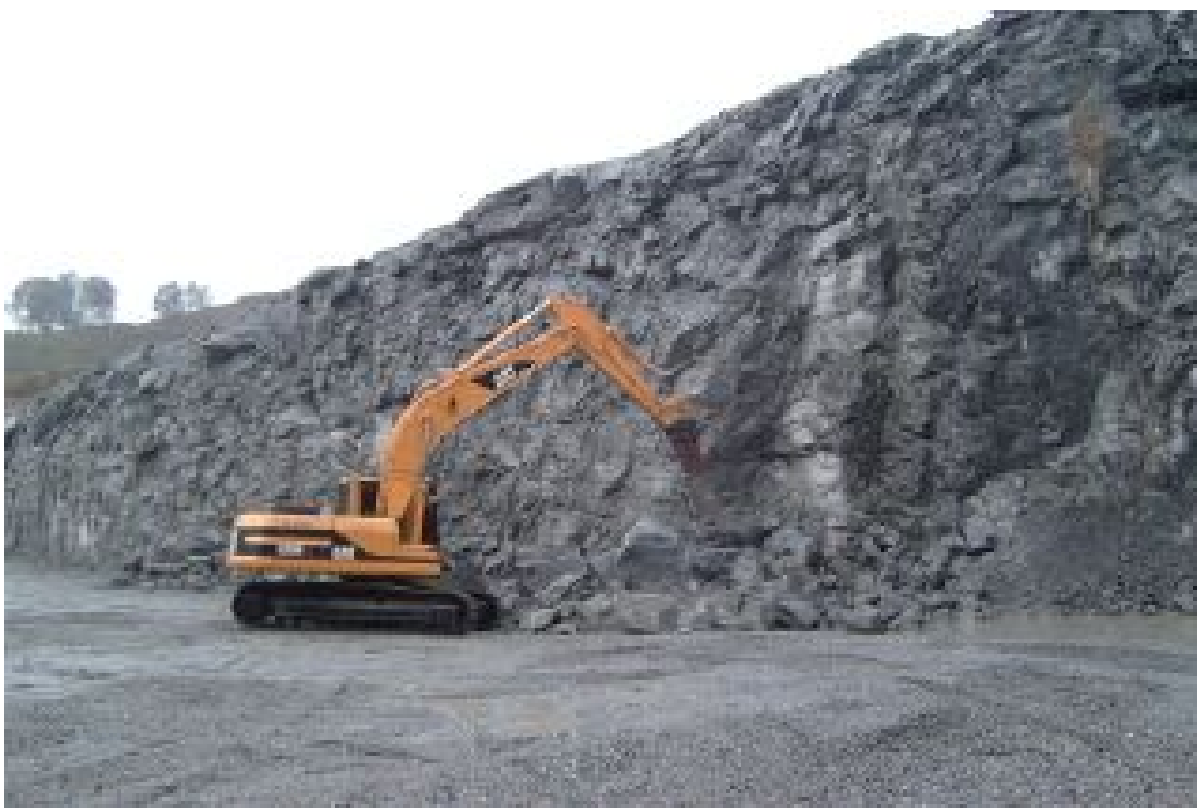
Foto 28 – Operação do rompedor hidráulico para redução secundária de rocha.
