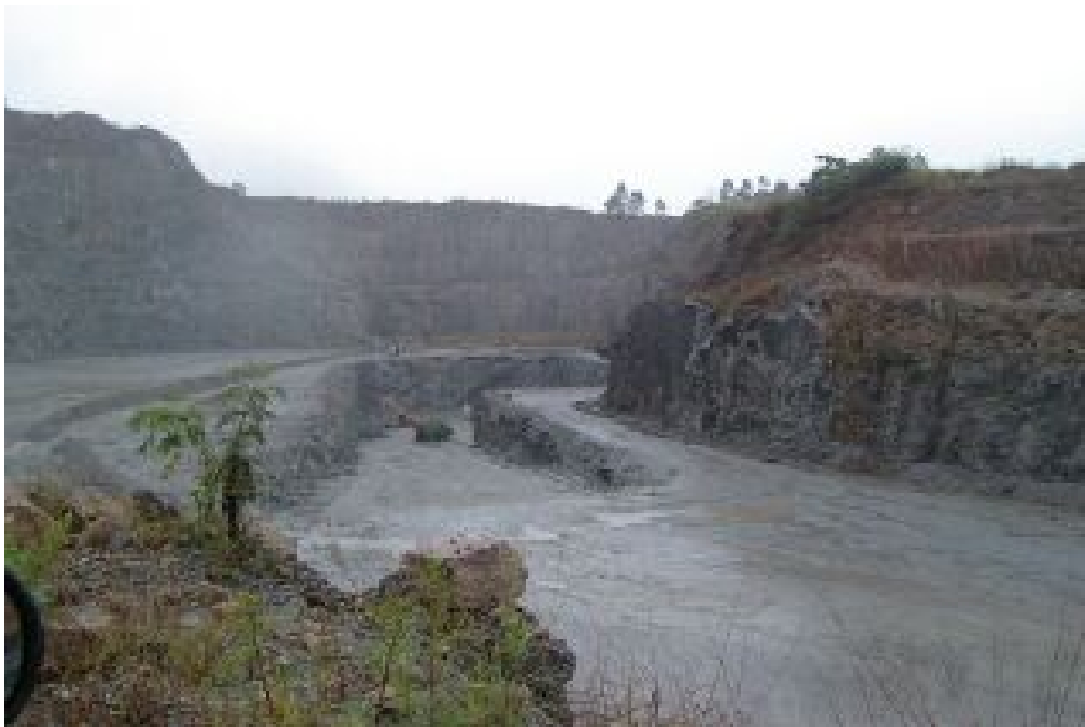
Foto 25 – Vista geral dos taludes incluindo rebaixamento do piso rochoso.
