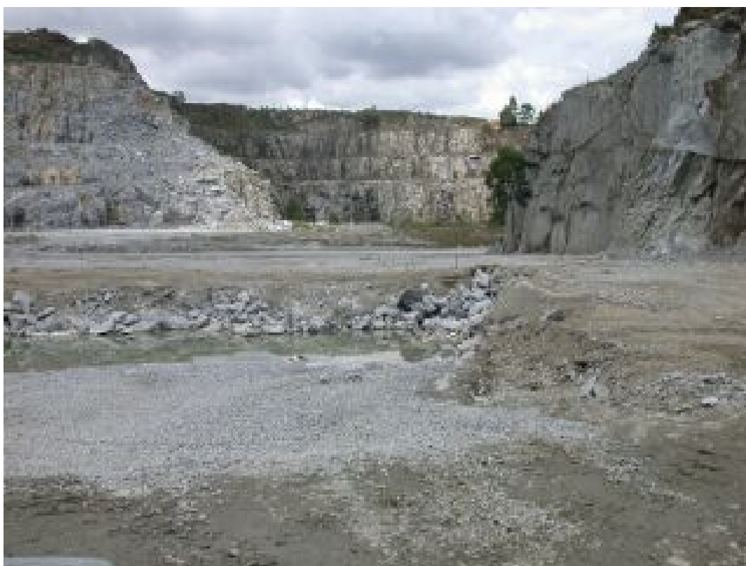
Foto 24 – Detalhe dos taludes formados em rocha (bancadas ao fundo).
