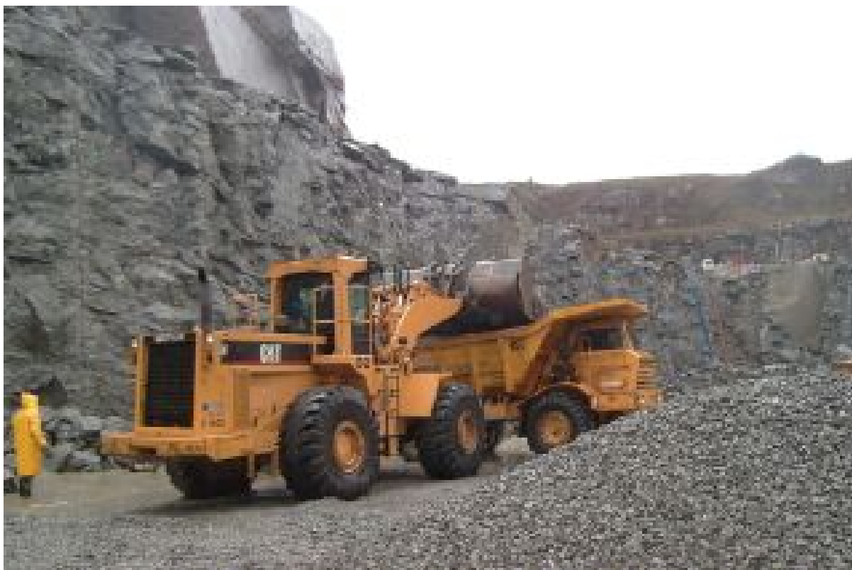
Foto 29 – Operação de carregamento dos blocos de rocha para transporte interno.
