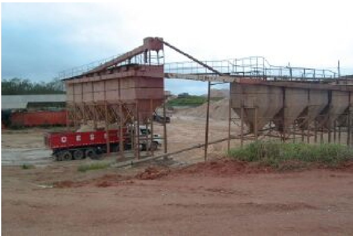
Foto 5 – Operação de carregamento de areia para transporte (Mineração Cessi).
