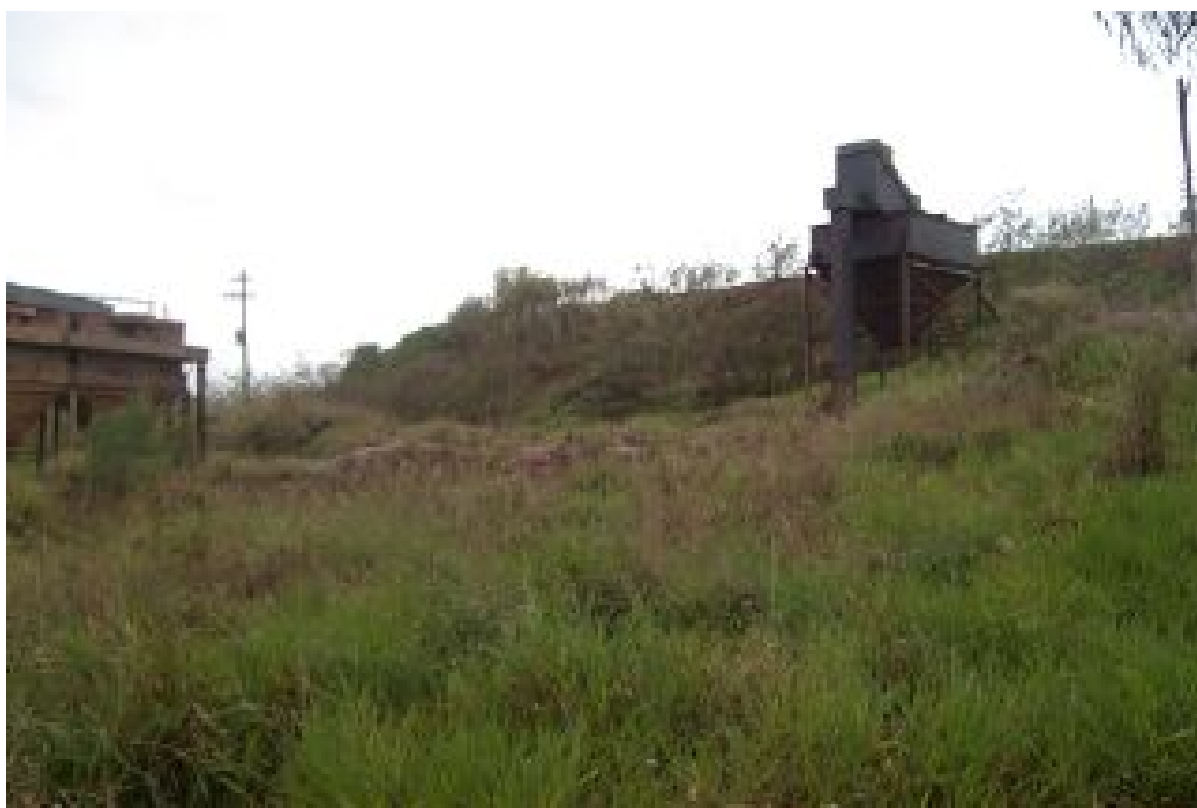
Foto 20 – Sistemas de lavagem e silos abandonados em área desativada (Mineração Candiú ou antiga Maria Rosa).
