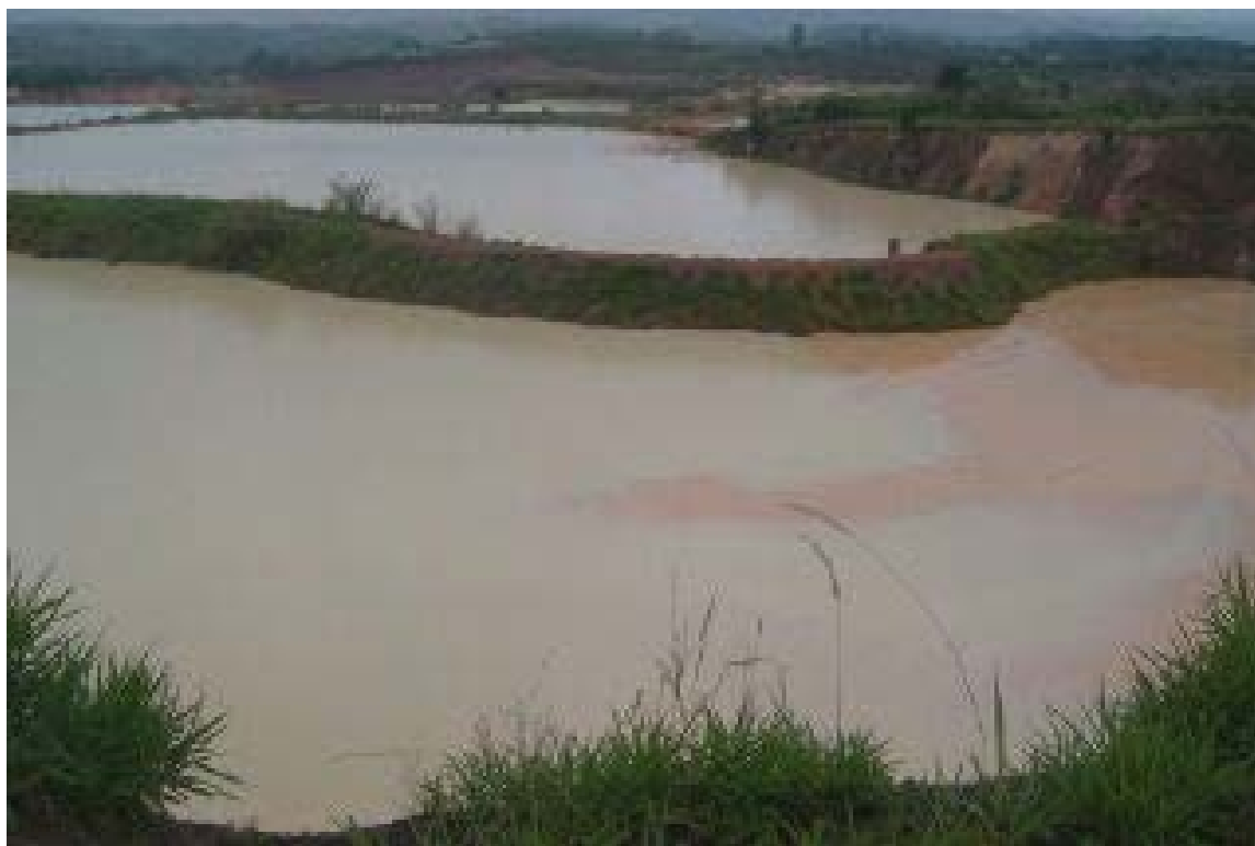
Foto 17 – Visão geral das bacias contíguas de armazenamento de água operacional e de disposição de rejeitos finos (Minerações Boa Sorte e Dutra).
