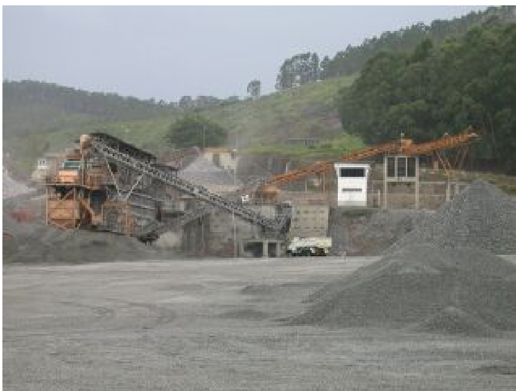
Foto 22 – Sistema de britagem com formação de pilhas de estocagem.
