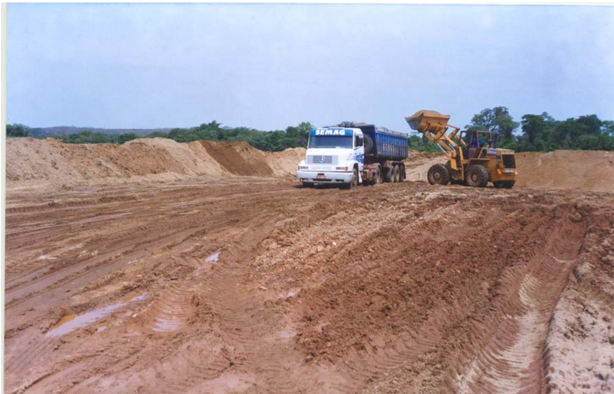
Foto 9 - Estoques de areia no porto de areia da SEMAG no rio Pardo.
