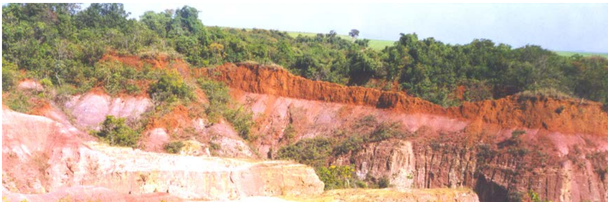
Foto 1 - Coberturas cenozóicas sobre sedimentos da Formação Aquidauana observadas em uma voçoroca.
