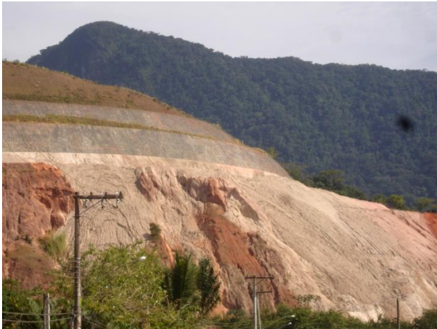
Foto 6- Mineração Ideal Terraplanagem – São Sebastião (LN – 05): parte superior da mina, onde se observa a recuperação da área minerada, com retaludamento e plantação de gramíneas.
