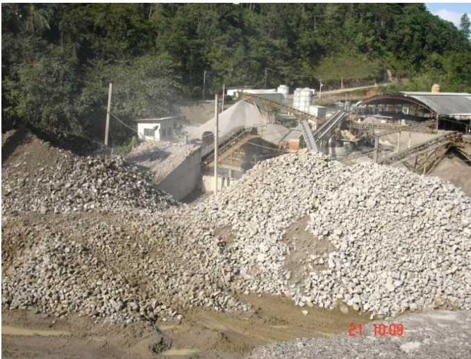
Foto 11 – Pedreira Massaguaçu (LN – 09) em Caraguatatuba: unidade de britagem secundária. Ao fundo (lado direito) situa-se usina de concreto e fábrica de artefatos de concreto.
