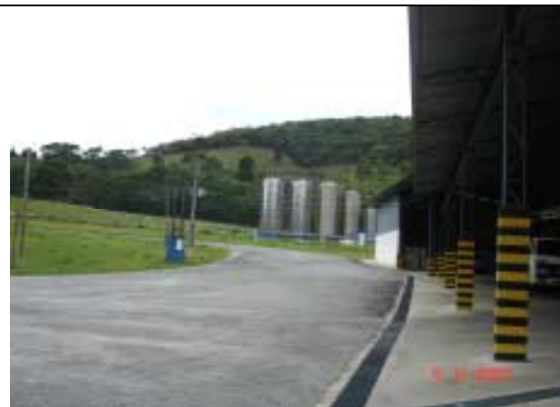
Foto 12 – Instalações da empresa Água Mineral Mata Atlântica.
