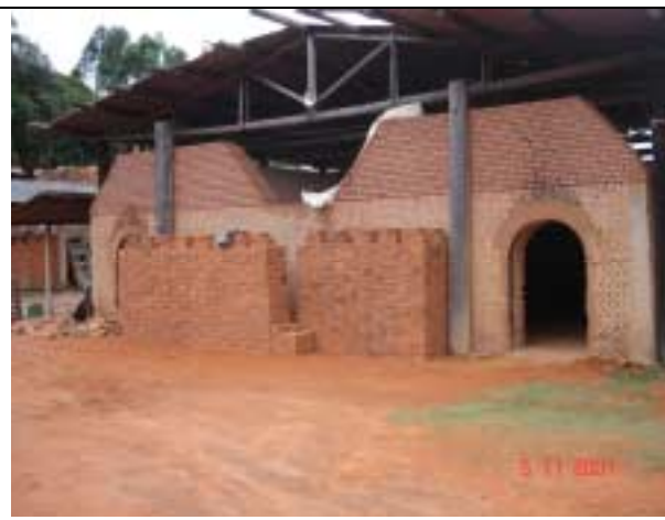
Foto 20 - Fornos do tipo abóbada com capacidade para 160 mil tijolos (Tino Olaria).
