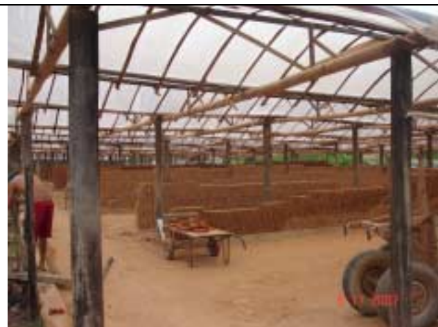
Foto 19 - Pátio com estufas para a secagem dos tijolos (Tino Olaria).
