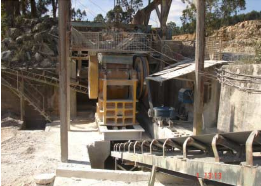
Foto 35 - Britador recém adquirido pela pedreira operando em fase experimental - Pedreira Anhanguera.
