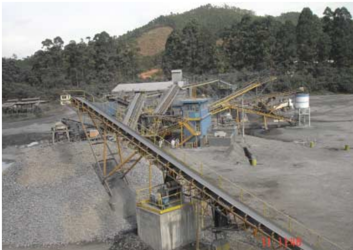
Foto 23 - Vista parcial da área de beneficiamento de brita calcária - Pedreira CJ/Votorantim.
