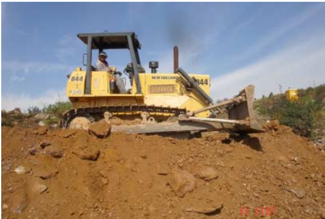
Foto 16 - Máquina operando no nivelamento da área de disposição de estéril - Pedreira CJ / Votorantim.
