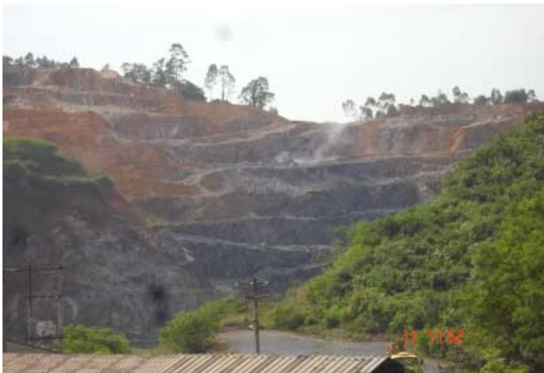
Foto 12 - Vista geral de área de avanço da lavra – Pedreira CJ / Votorantim.
