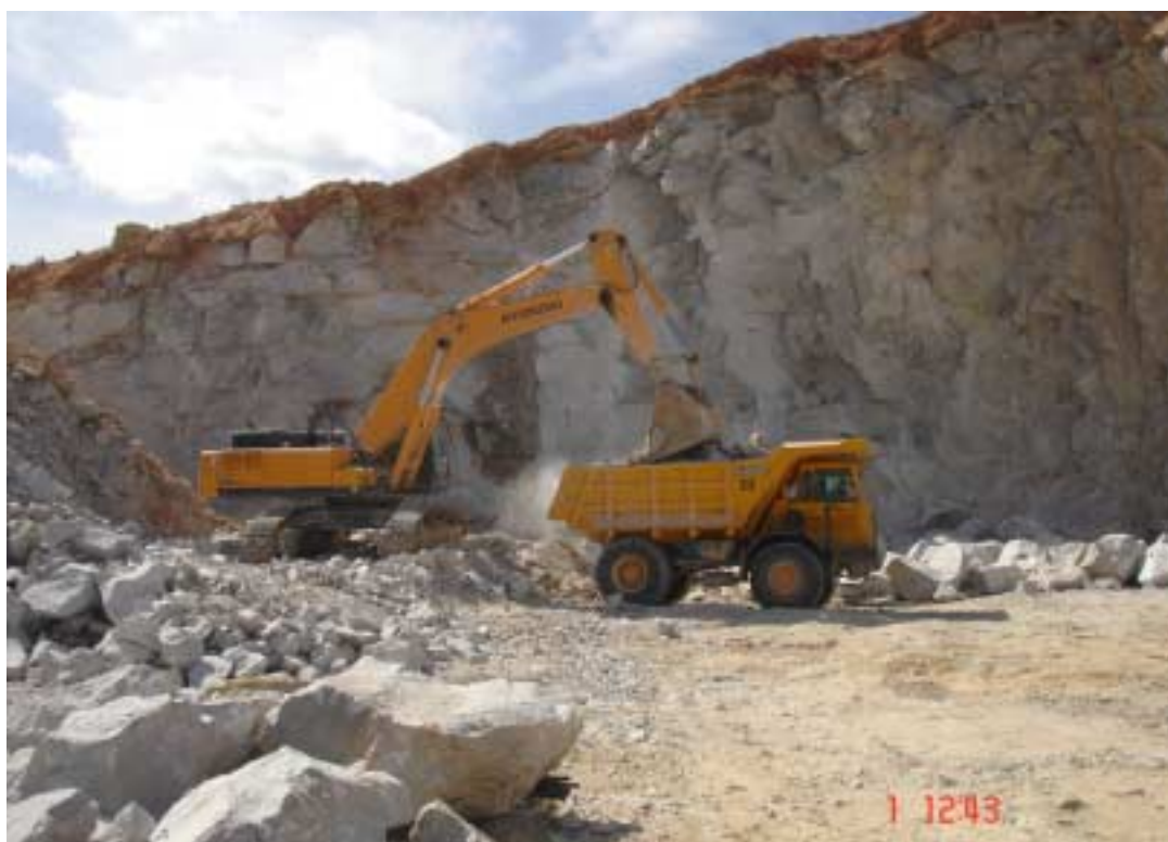
Foto 28 - Operação de carregamento após desmonte rochoso - Pedreira Anhanguera.
