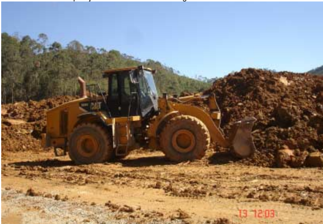
Foto 8 – Operação de nivelamento de área de disposição de estéril – Pedreira Khouri/Lafarge.
