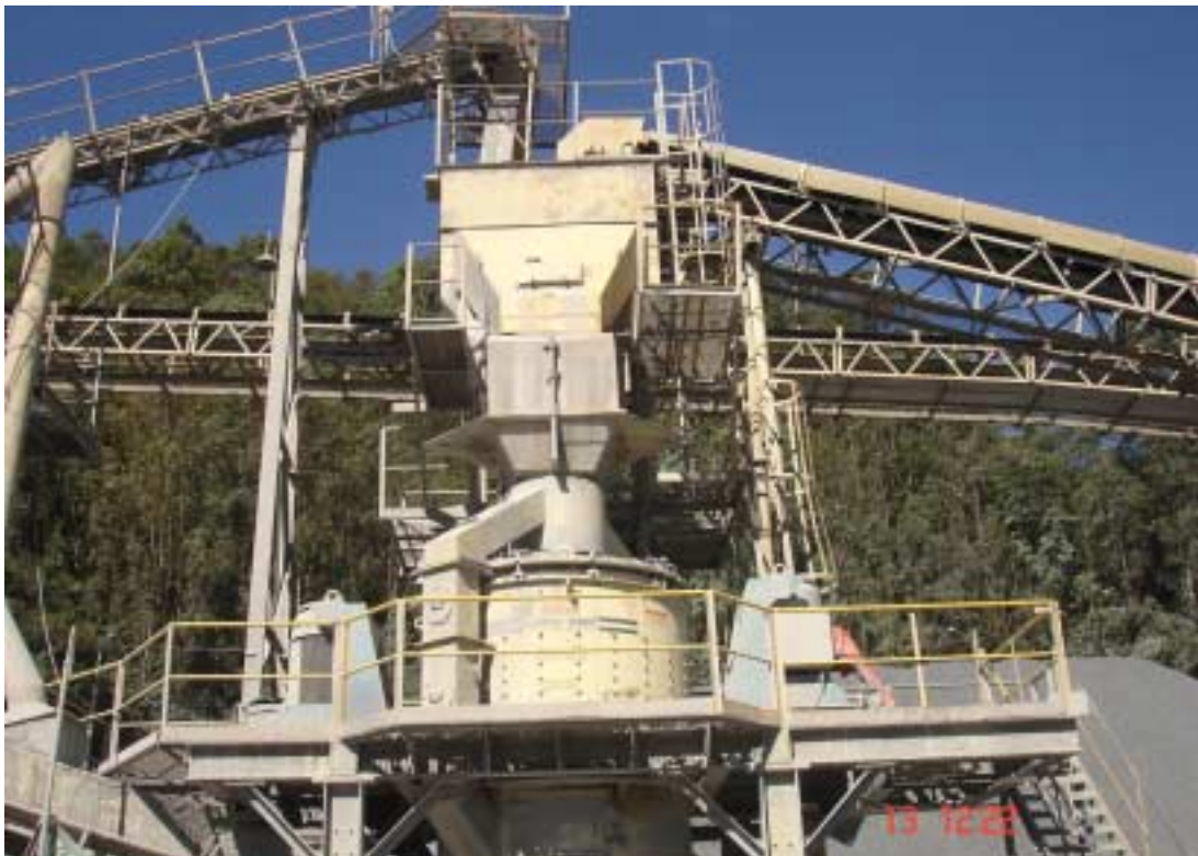
Foto 10 - Equipamento de britagem em estágio secundário - Pedreira Khouri/Lafarge.
