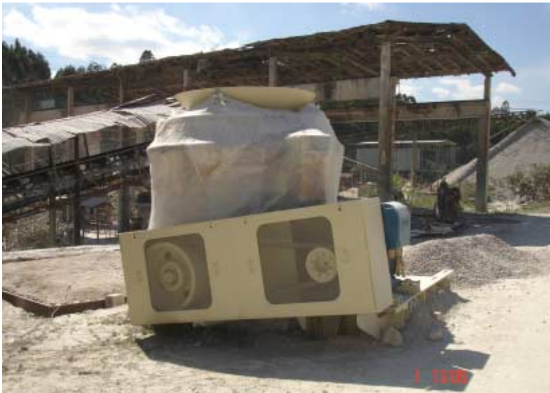
Foto 34 – Britador novo a ser instalado - Pedreira Anhanguera.
