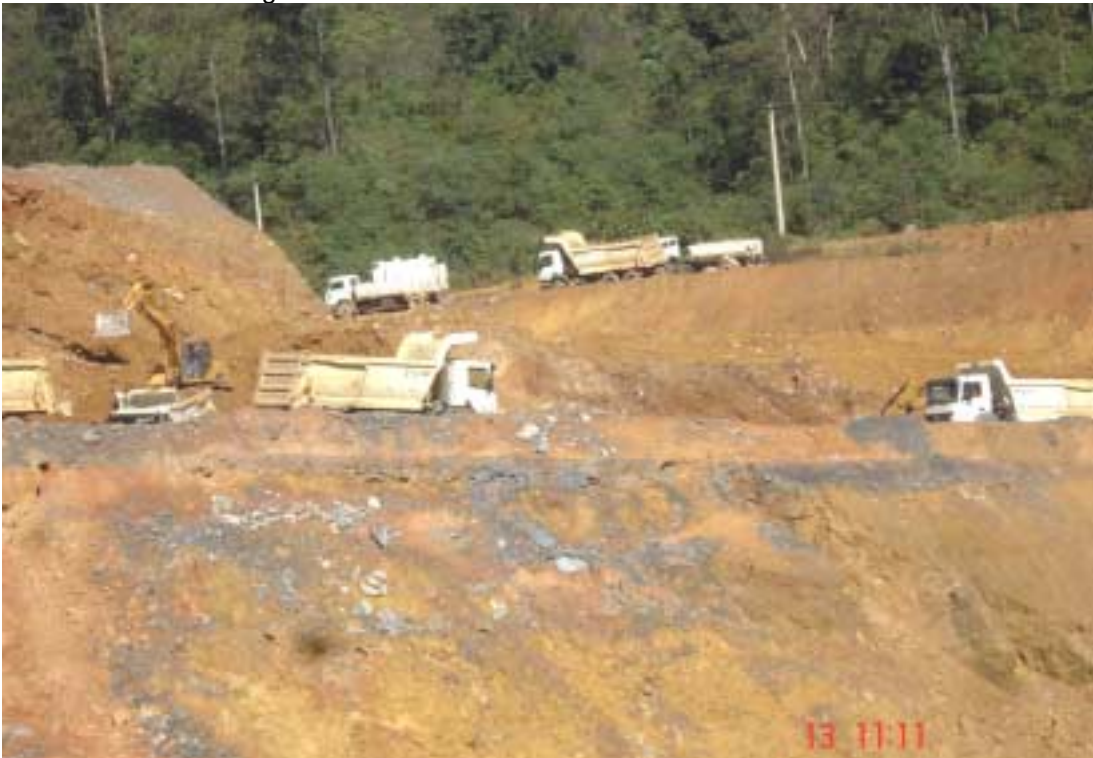
Foto 6 - Movimentação intensa de caminhões de transporte de estéril em área para ampliação do pit atual - Pedreira Khouri/Lafarge.
