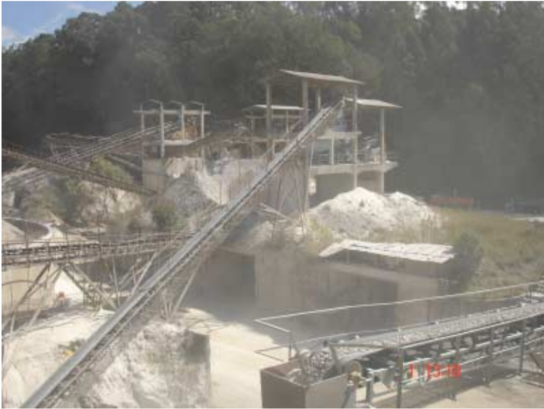
Foto 33 - Vista parcial da área de beneficiamento de brita - Pedreira Anhanguera.
