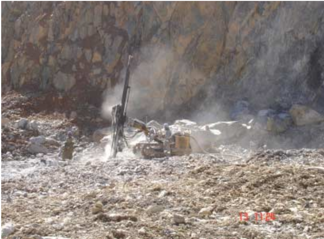
Foto 3 - Perfuração de rocha em bancada de lavra - Pedreira Khouri/Lafarge.
