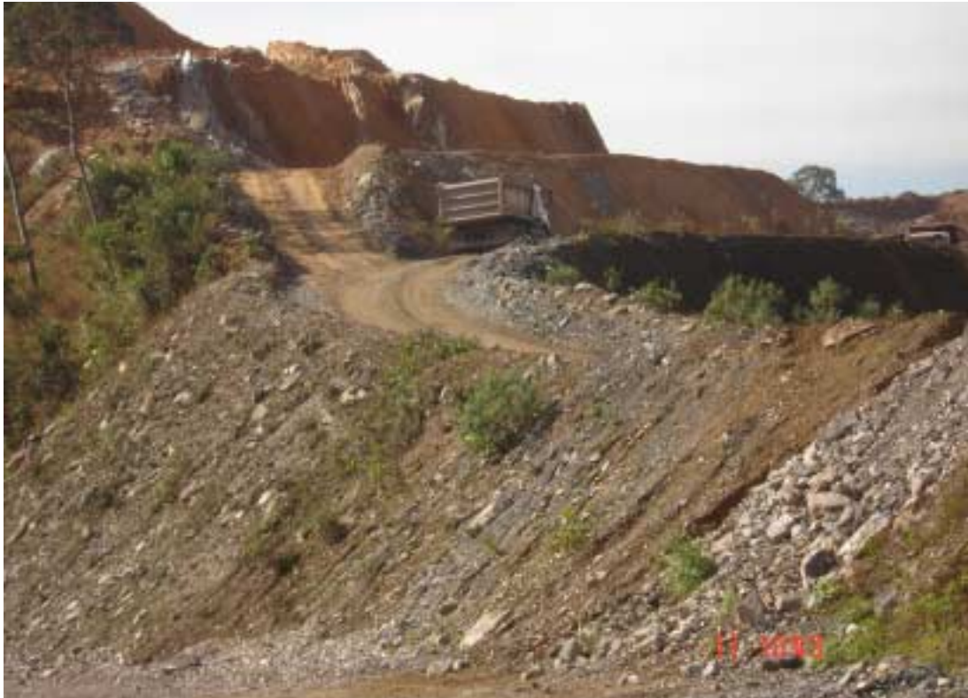
Foto 13 - Local de retirada de estéril para retaludamento da lavra - Pedreira CJ / Votorantim.
