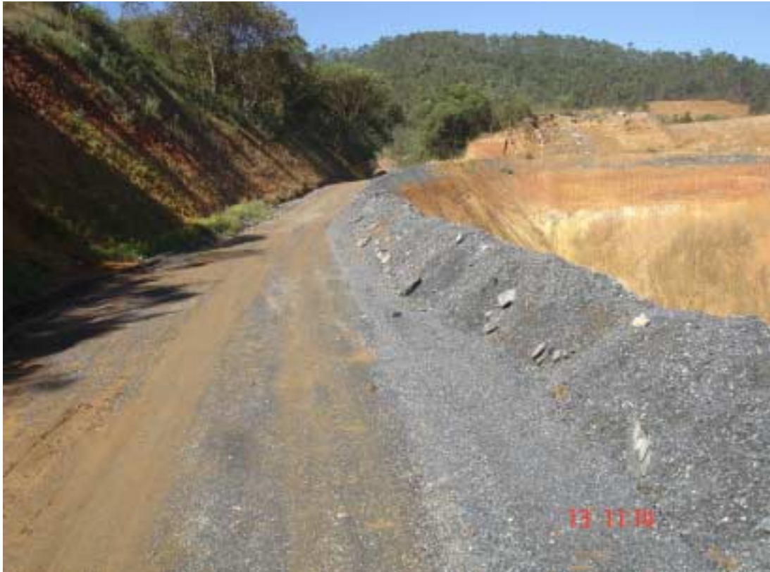
Foto 5 - Formação de leiras de segurança nas vias de transporte interno da mina - Pedreira Khouri/Lafarge.
