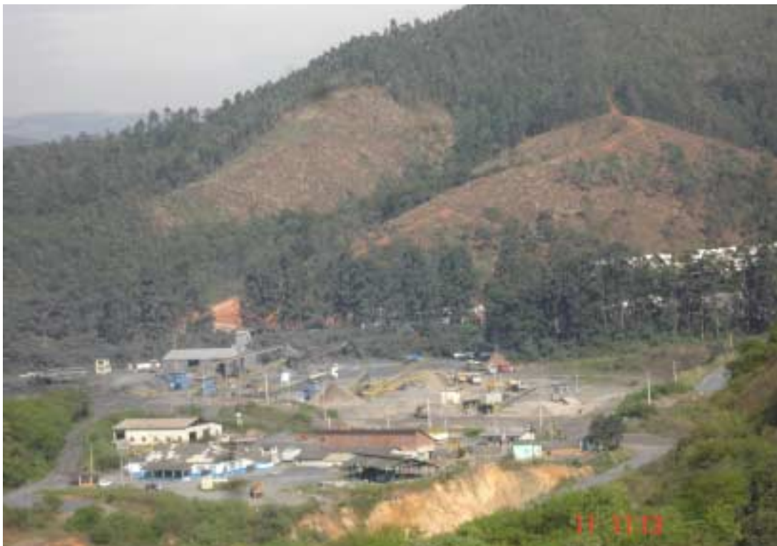
Foto 18 - Vista geral das instalações de beneficiamento- Pedreira CJ / Votorantim.
