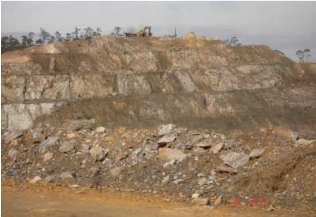
Foto 17 - Ao topo, operações de retirada de capeamento para avanço das frentes de lavra - Pedreira CJ / Votorantim.
