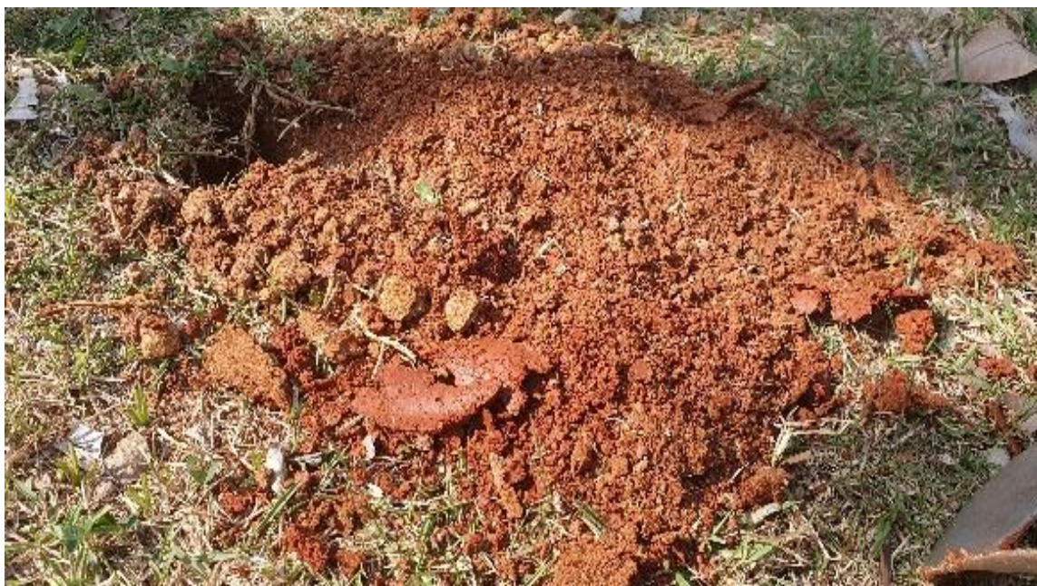
Figura 23: Material de recobrimento utilizado para paisagismo disposto sobre os resíduos sólidos, Fonte: Marcio Rossi, 2024.
