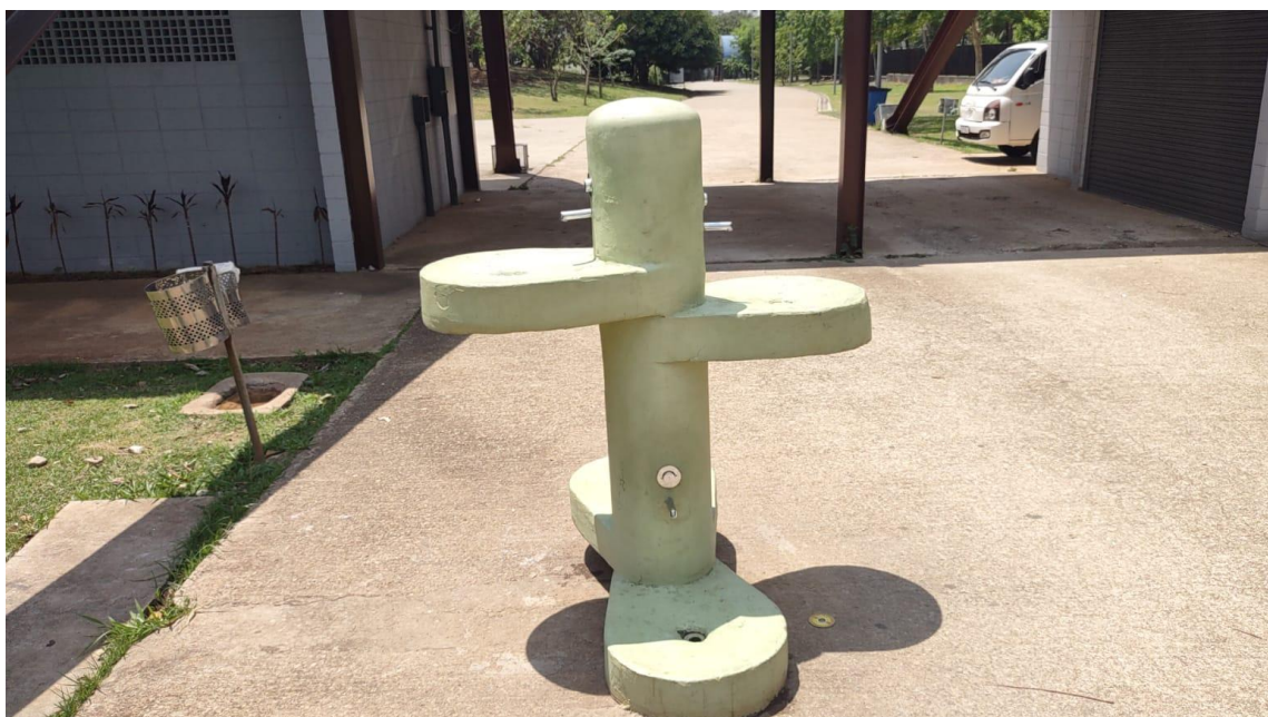
Figura 45. Bebedouro tubular de concreto. Fonte: Diretoria de Parques Urbanos, 2024.
