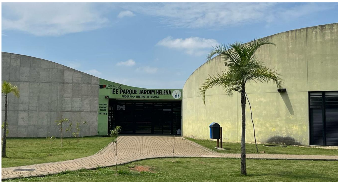
Figura 90. E.E. Parque Jardim Helena. Fonte: Diretoria de Parques Urbanos, 2025.
