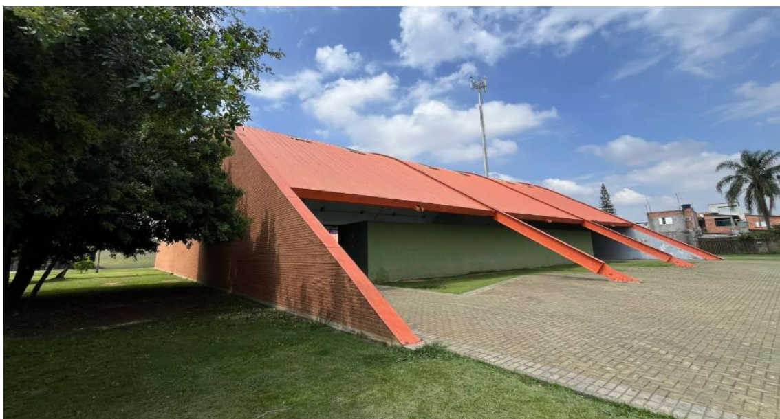
Figura 67. Pavilhão multiuso. Fonte: Diretoria de Parques Urbanos, 2025.
