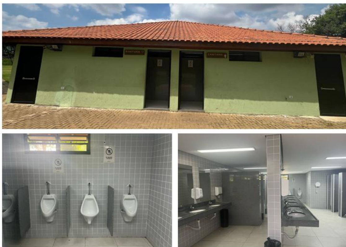
Figura 88. Módulo de sanitários e parte interna. Fonte: Diretoria de Parques Urbanos, 2025.
