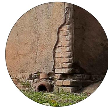
1 - FOTO DETALHE DESTACAMENTO DE ARGAMASSA COM TIJOLO APARENTE
