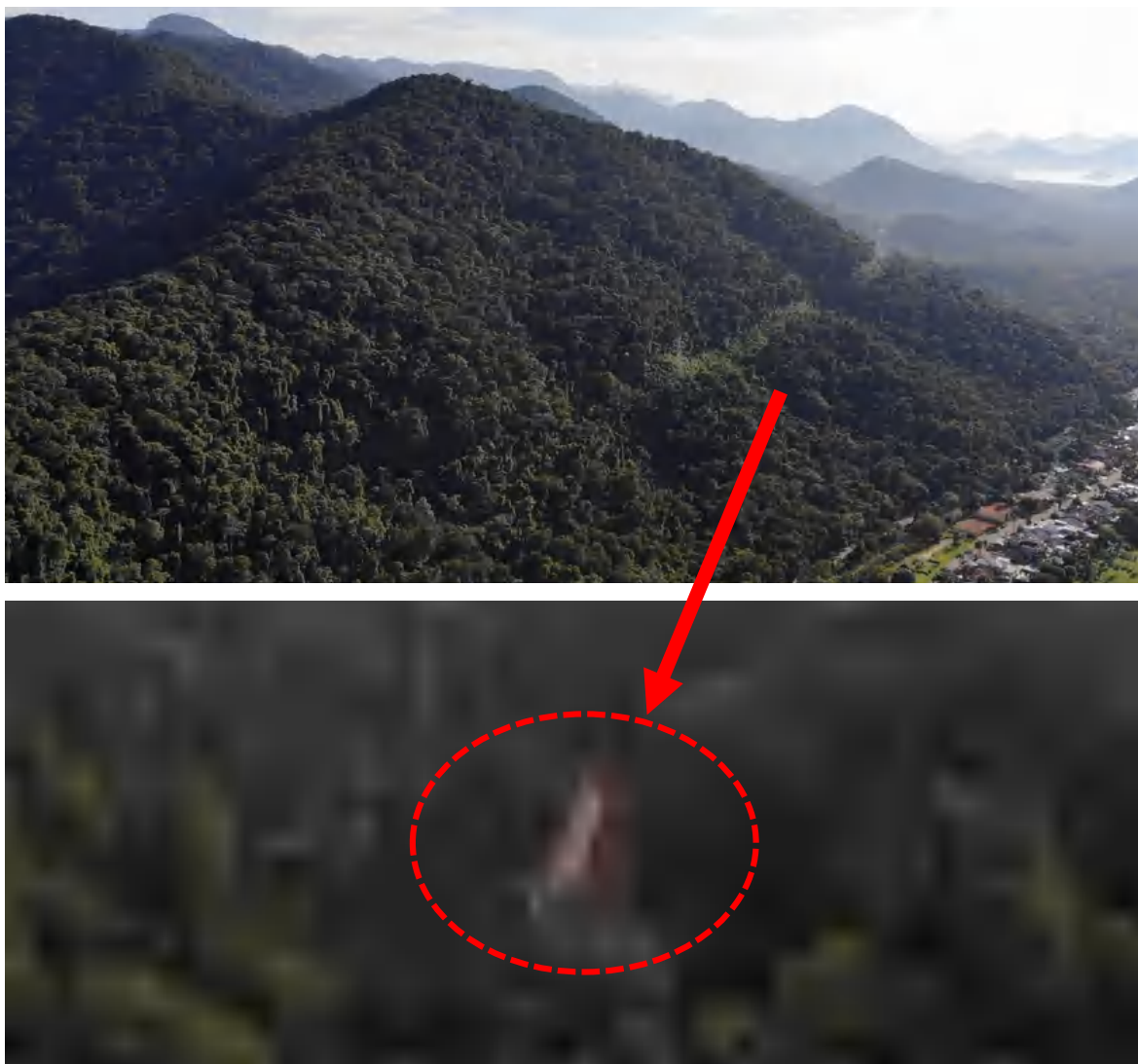
Figuras 210 e 211: Encostas com elevada declividade e solos rasos.
