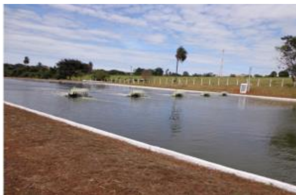
Foto 68: Lagoa de Estabilização (tratamento).
