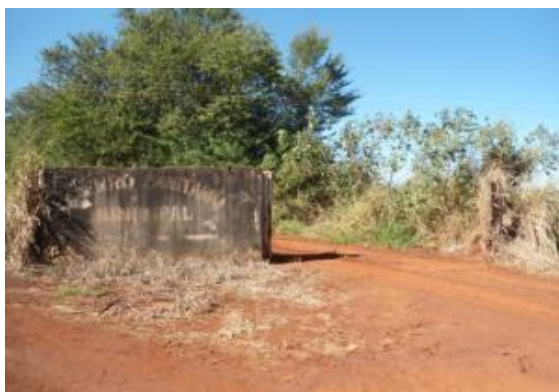
Foto 13: Entrada do aterro sanitário.
