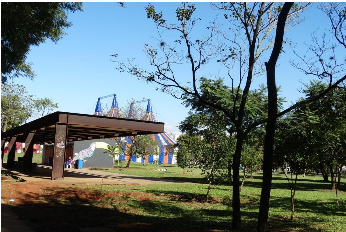
Figura 91. Módulo de sanitários do setor institucional do Parque da Juventude – Dom Paulo Evaristo Arns. Fonte: Coordenadoria de Parques e Parcerias, 2023.
