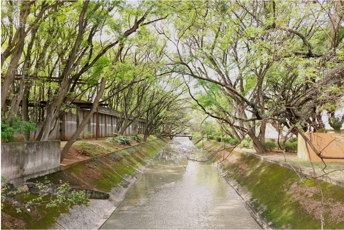
Figura 52. Ruínas e tipuanas do Setor Central. Fonte: Coordenadoria de Parques e Parcerias, 2023.
