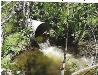
**Figura 10.** Galeria para travessia de curso d'água com queda na saída do emboque e subdimensionada.
