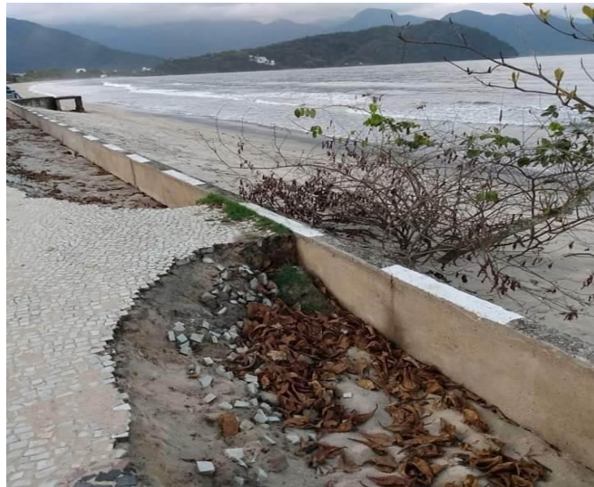
Figura 7: Praia de Iperoig – calçadão destruído após uma ressaca ,destaque para a proteção exercida pela única vegetação existente
