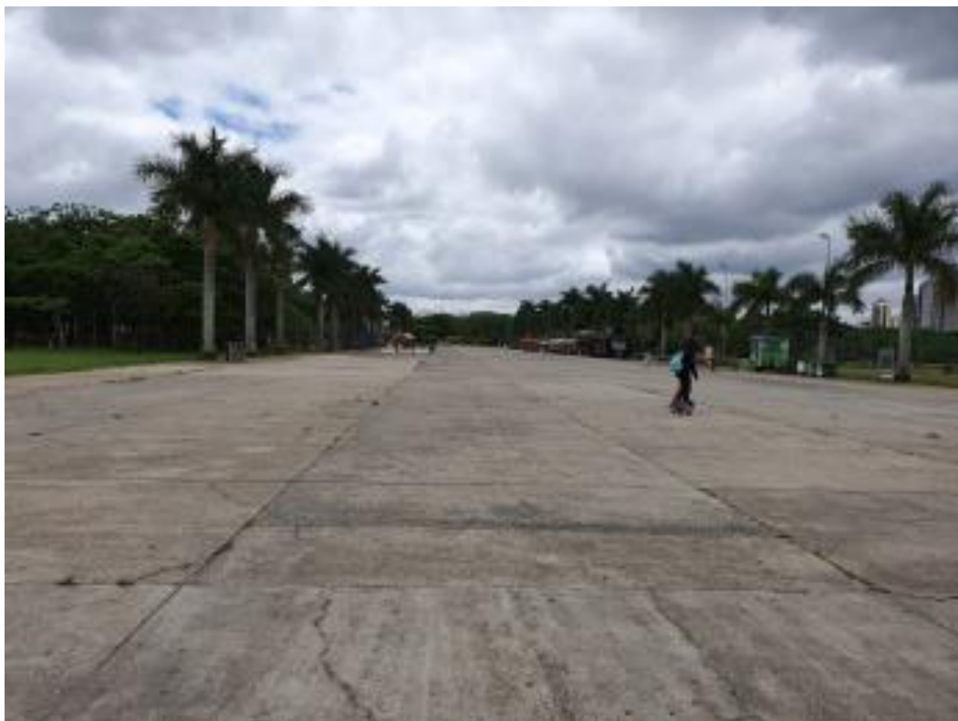
Imagem 16 - Extensas áreas impermeabilizadas e edificações.
