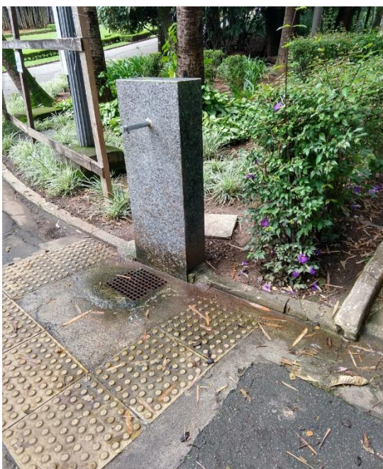
Imagem nº 57. Bebedouro b) acessível, implantado em 2018, com torneira com temporizador. Fonte: Coordenadoria de Parques e Parcerias – SIMA/SP, 2020.
