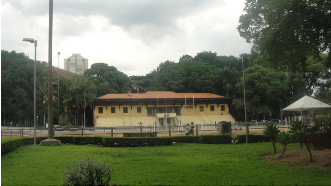
Imagem nº 89. Vista do prédio da Administração do Parque. Fonte: Acervo Coordenadoria de Parques e Parcerias - SIMA/SP, 2020.
