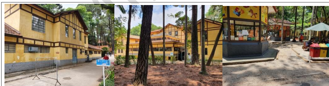
Imagem nº 6: Áreas com edificações e construções para escritórios e comércio e recreação.
