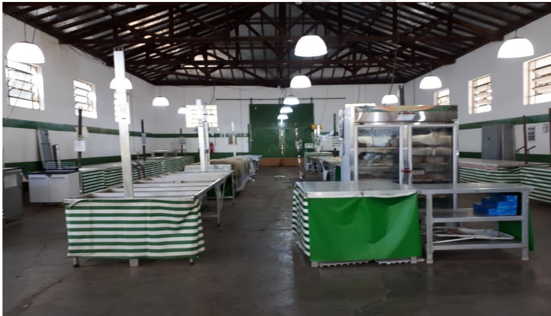
Imagem nº 101. Espaço interno Galpão Feira Orgânica. Fonte: Acervo Coordenadoria de Parques e Parcerias - SIMA/SP, 2020.
