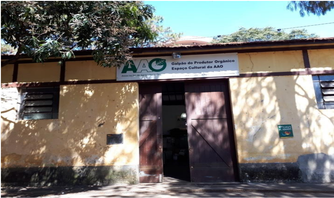
Imagem nº 100. Entrada Galpão Feira Orgânica - AAO. Fonte: Acervo Coordenadoria de Parques e Parcerias - SIMA/SP, 2020.
