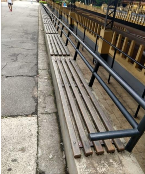
Imagem nº 55. Banco em acabamento de madeira sobre os muros de arrimo. Fonte: Coordenadoria de Parques e Parcerias - SIMA/SP, 2020.
