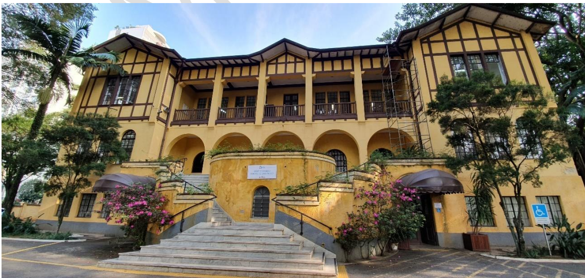
Imagem nº 90. Prédio Fundo Social de São Paulo. Fonte: Acervo Coordenadoria de Parques e Parcerias - SIMA/SP, 2020.
