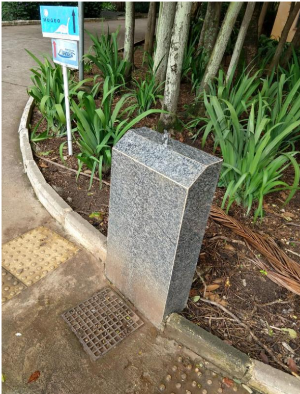
Imagem nº 58. Bebedouro c) semelhantes ao anterior, com chanfro na parte superior e torneira padrão de bebedouro. Fonte: Coordenadoria de Parques e Parcerias – SIMA/SP, 2020.
