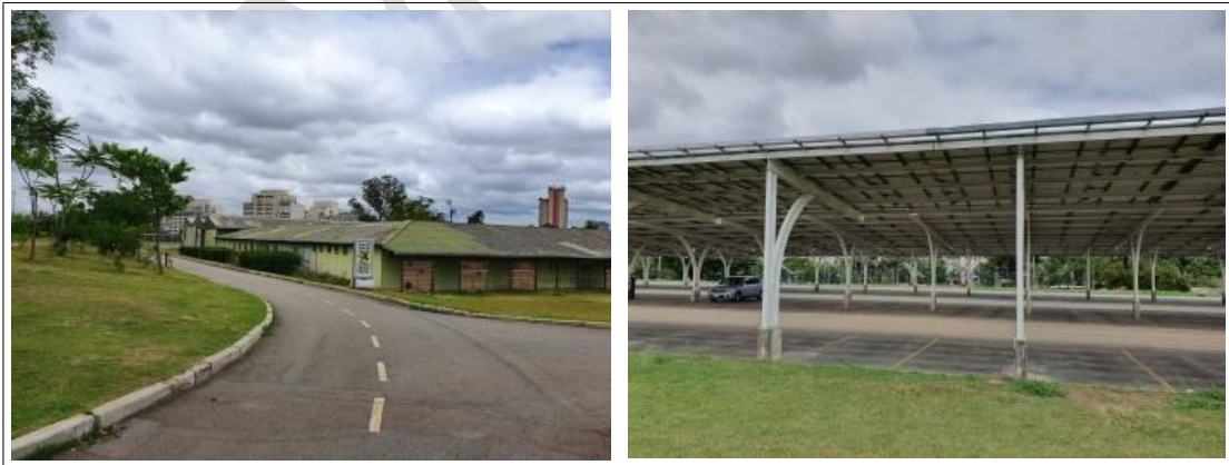
Imagem 12 - Extensas áreas impermeabilizadas e edificações.
