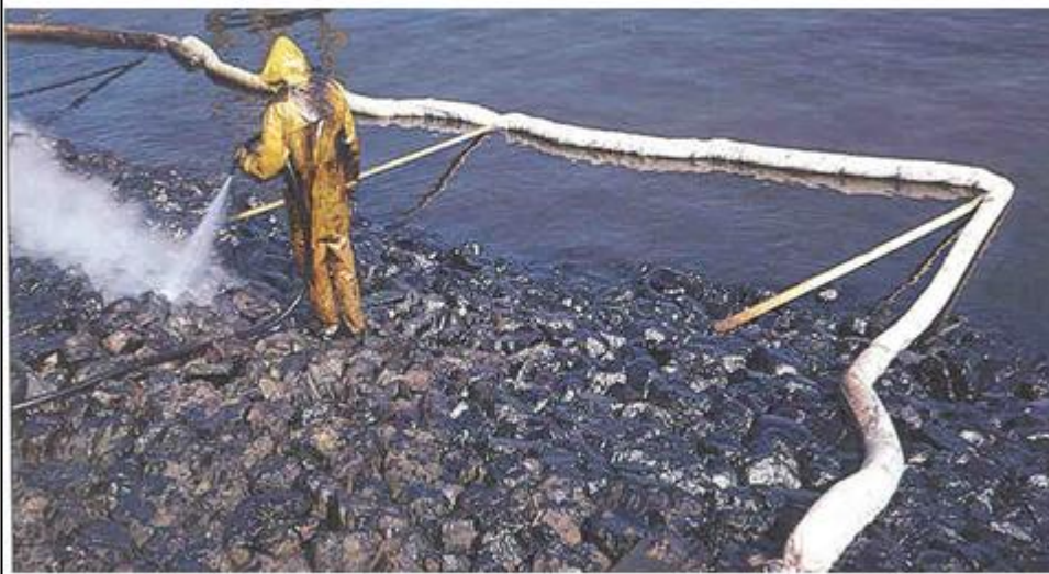
JATEAMENTO BAIXA PRESSÃO Controle dos resíduos oleosos gerados
