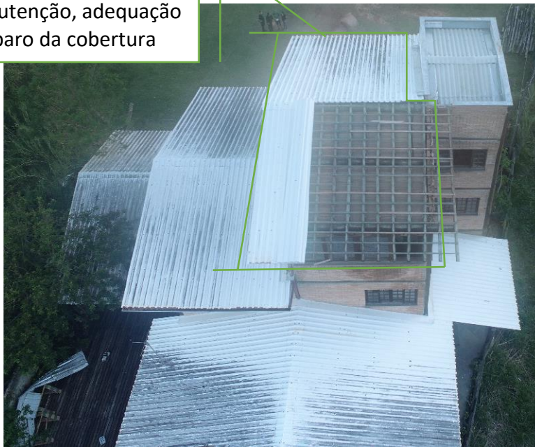
Foto 3: Cobertura - Trecho de intervenção
