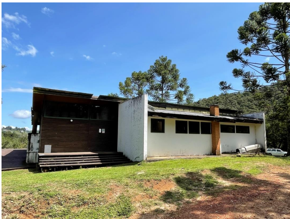
Figura 1 – Foto do Alojamento do Parque Estadual dos Mananciais de Campos do Jordão.
