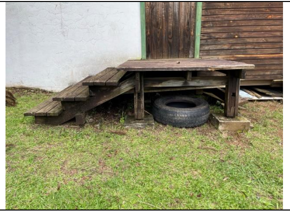
Figura 9– Escadaria de acesso lateral.
