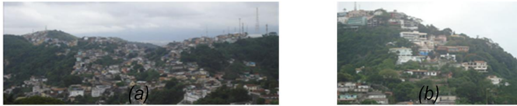
Figura 16 - Zonas sujeitos a riscos geodinâmicos (escorregamentos e movimentos de massa) e densidade populacional: (a) moradias em áreas de risco de escorregamento na vila Progresso (BARBI, 2014); (b) vista para os morros José Menino e Santa Therezinha[registro fotográfico de J.C. Carvalho]. Fonte: IWAMA, 2014; IWAMA et al. (prelo).
