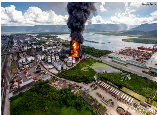
Figura 87 – Acidente em tanque de combustíveis em Alemoa, 2015 Fonte: g1.globo.com
