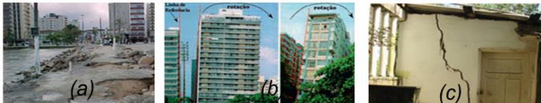
Figura 15 - Zonas sujeitos a riscos geodinâmicos (inundação, subsidência do solo e efeitos da elevação do nível mar) e densidade populacional: (a) erosão costeira na orla de Santos (AMARAL & GUTJAHR, 2011); (b) subsidência em edifício no centro de Santos, praia do Boqueirão (TOMINAGA et al., 2009); (f) ruptura em moradia causada por subsidência do solo em São Vicente (AMARAL; & GUTJAHR, 2011). Fonte: IWAMA, 2014
