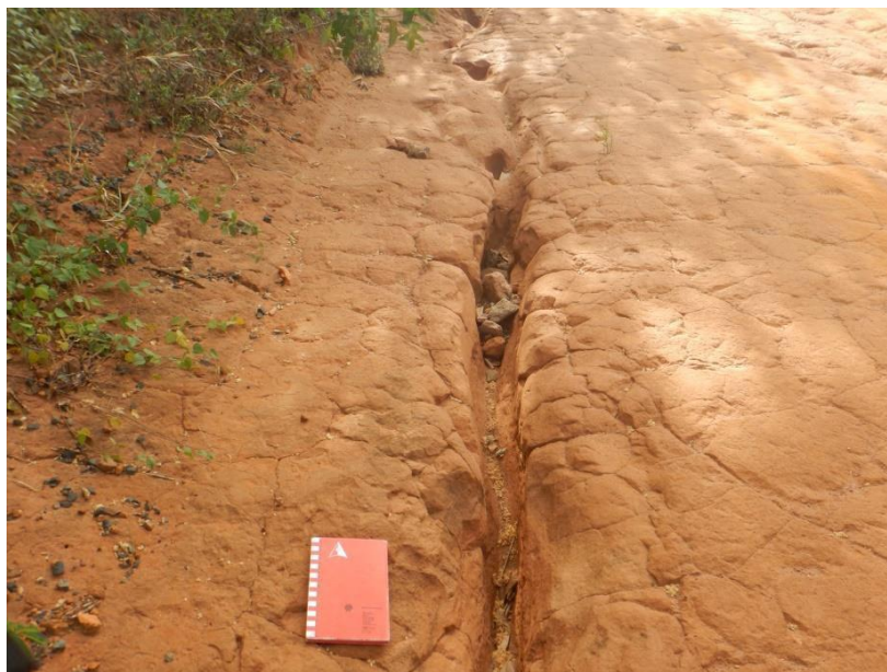
Apêndice 2.2.3.O. Feição erosiva em estrada no interior da FENP em área de ocorrência de Argissolo.
